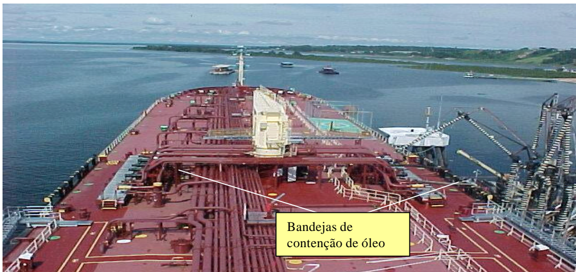
Fig.4.3 - Bandejas de contenção de vazamentos abaixo das tomadas de carga.
