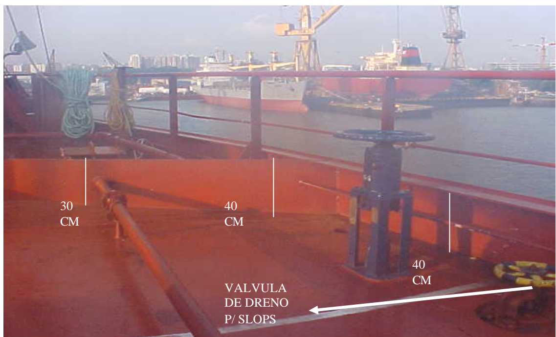
Fig.4.4 – Trincaiz elevado suas medidas e válvula de dreno do convés para os slops tanks.
