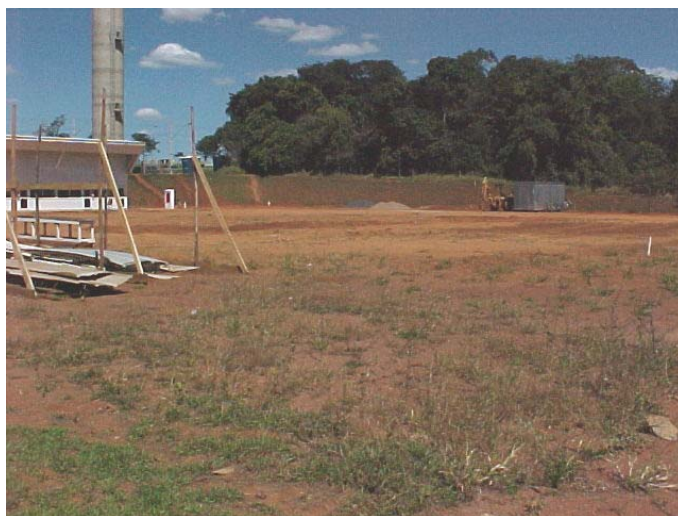
Início de obra - Sede da UNIALGAR em Uberlândia - MG.
