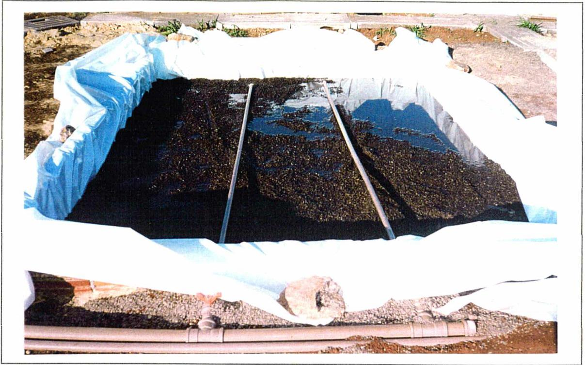
**Figura 14:** Foto ilustrativa de um módulo BioFiltro com Macrófita saturado com água.
