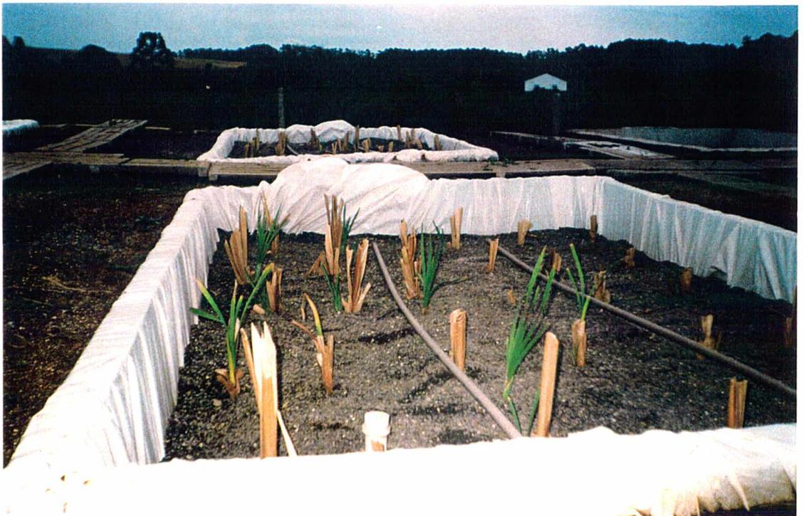
**Figura 16:** Fotos ilustrativas dos módulos BioFiltros 1 e 3 após estarem colmatados (em detalhe o BioFiltro 1 - foto superior) e dos módulos BioFiltros 2 e 4 (em detalhe o BioFiltro 2 - foto inferior).
