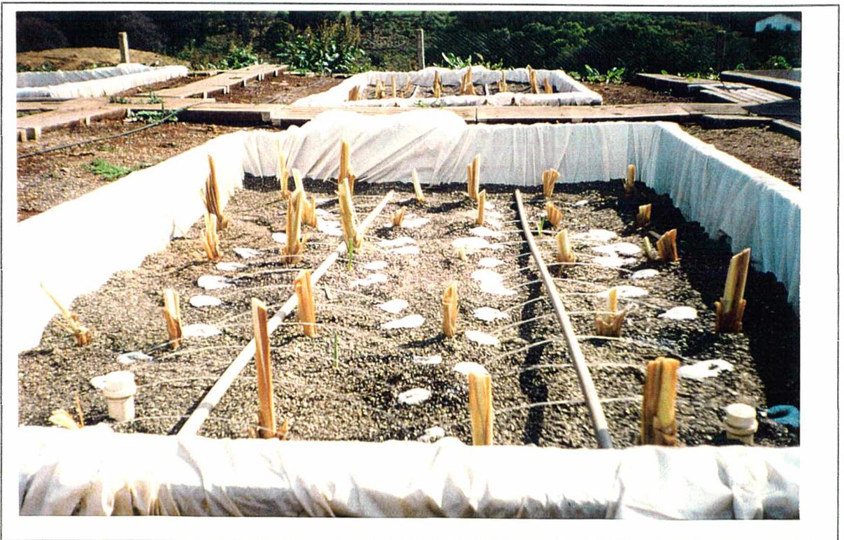
**Figura 15:** Foto ilustrativa do sistema de alimentação - após início do período de aplicações intermitentes.
