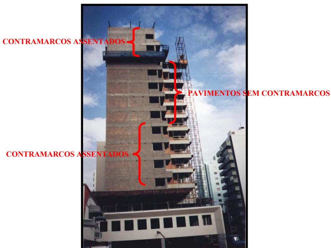
Figura 4.3: Descontinuidade da colocação dos contramarcos.
