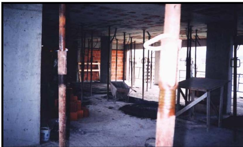
Figura 4.2: Antecipação na execução da alvenaria.
