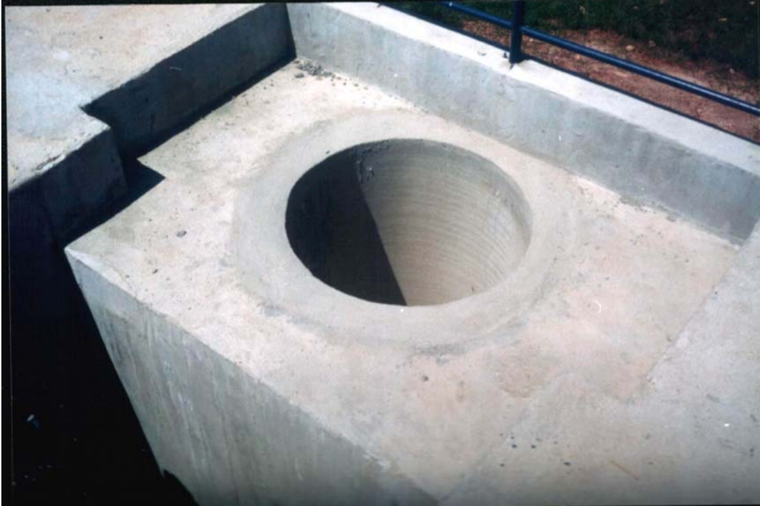
FIGURA 37 – TRATAMENTO PRELIMINAR: CAMARA DE TRANQUILIZAÇÃO (CT) E EXTRAZOR.
