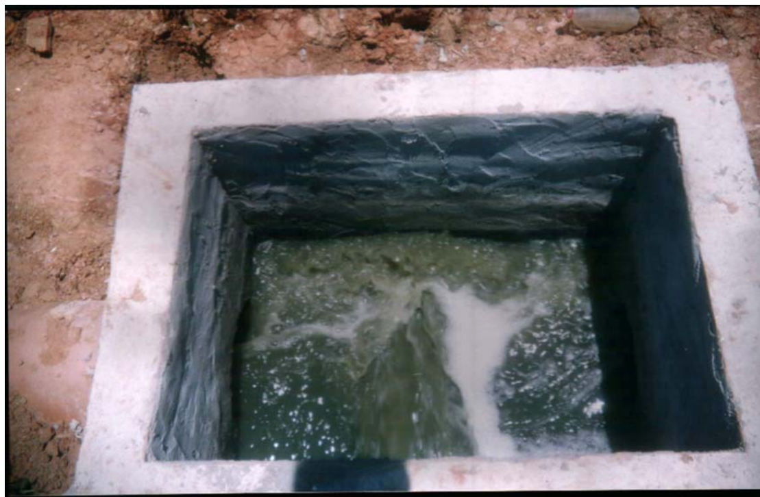
FIGURA 34 – (CE-TQ3) NA LAGOA ANAEROBIA (LA-1).
