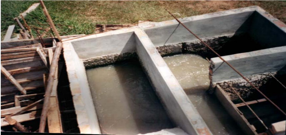
FIGURA 12 – CÂMARA DE TRANQUILIZAÇÃO (CT) E CÂMARA EQUIPARTIDORA DE VAZÃO (CEV).
