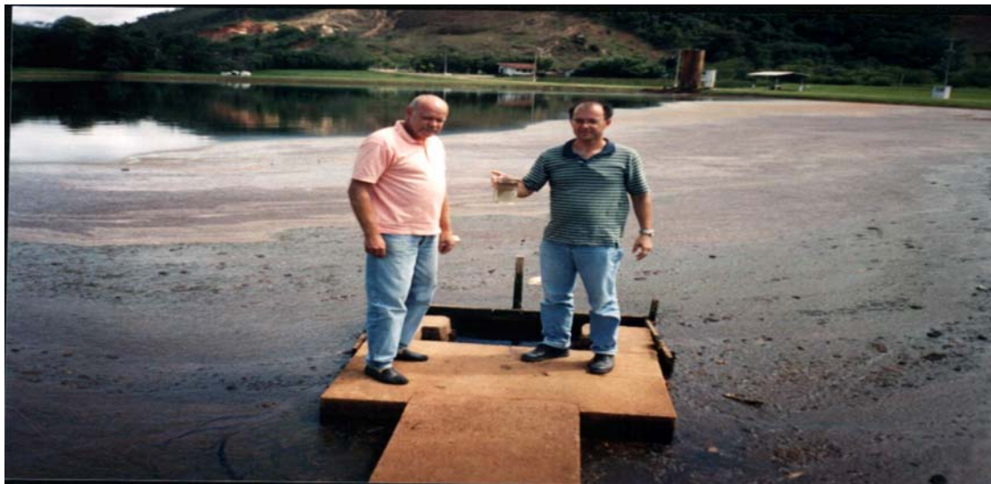
FIGURA 22 – (LF-E) OU (L-L), SOBRENADANTES, (CE-8) E PASSARELA DE ACESSO A MESMA, E LÍQUIDO CLARIFICADO QUE É CONDUZIDO PARA A (LF-2).
