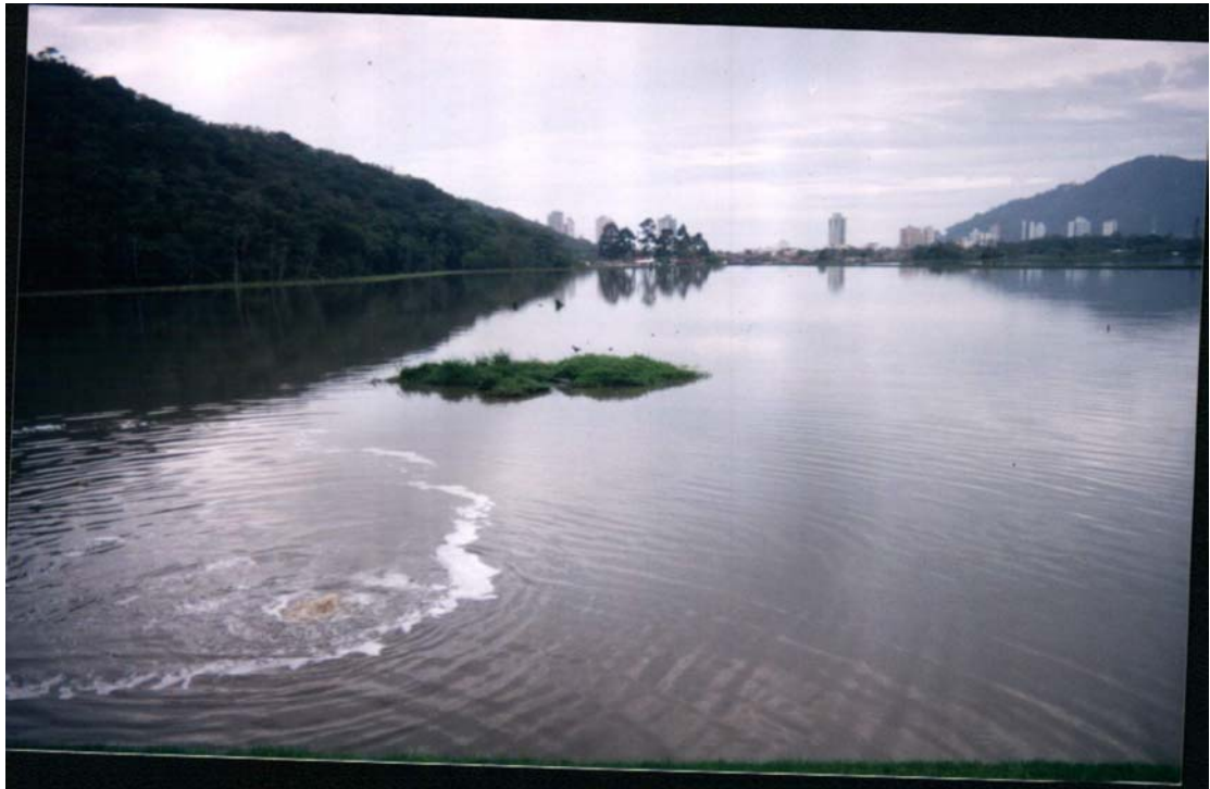
FIGURA 25 – EFLUENTE DA (LA-1) LANÇADO NA (LF-1), VEGETAÇÃO AQUÁTICA E ESPUMA.
