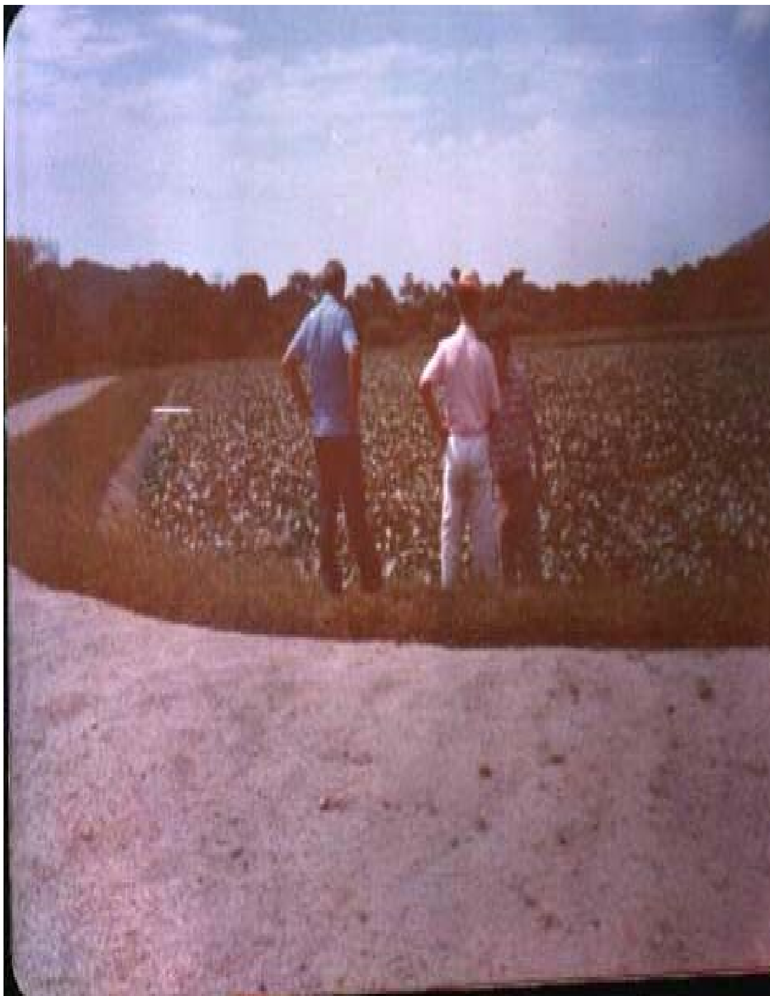
FIGURA 2: LAGOA DE OXIDAÇÃO DO STE DA SEDE DO MUNICÍPIO DE BALNEÁRIO CAMBORIÚ, SC, COM CULTIVO DE AGUAPÉ, NO MÊS DE JANEIRO DE 1981.
