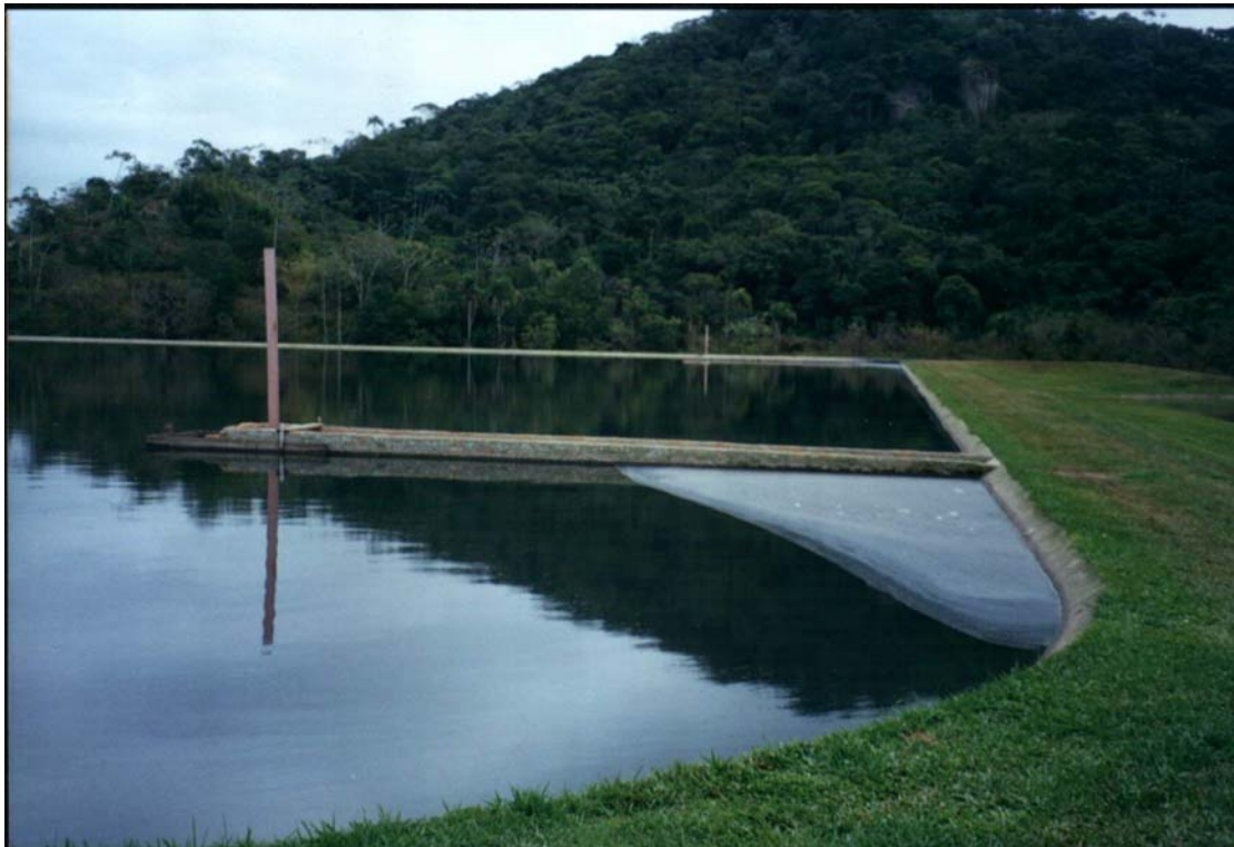
FIGURA 13 – LAGOA ANAERÓBIA 1 (LA-1): PASSARELAS DE ACESSO AS , (CE-2 E CE-3) E SOBRENADANTES.
