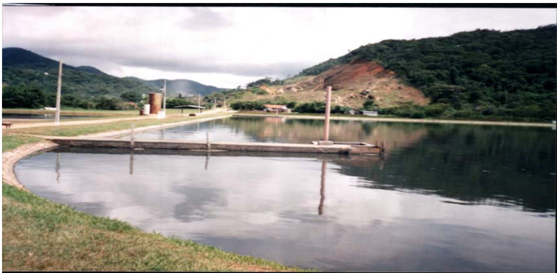
FIGURA 14 – LAGOA ANAERÓBIA 2 (LA-2) PASSARELAS DE ACESSO AS (CE-4 E CE-5) E CONTIGUAMENTE A (CE-4) A CAIXA DO (R-3).
