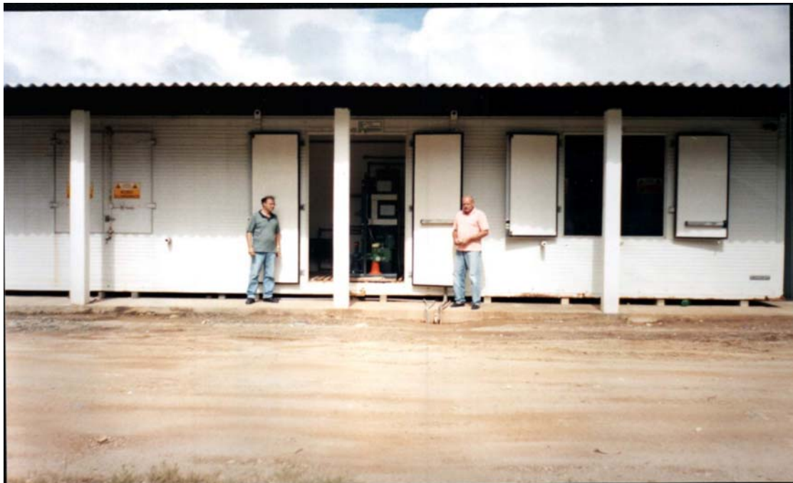
FIGURA 32 – CASA DE QUIMICA (C.Q) ONDE É ARMAZENADO E ESTOCADO O ÁCIDO CLORÍDRICO, O CLORITO DE SÓDIO E OS EQUIPAMENTOS DESTINADOS A FABRICAÇÃO E DOSAGEM DE DIÓXIDO DE CLORO PARA SER APLICADO NO CANAL BY-PASS: (C.B.P).
