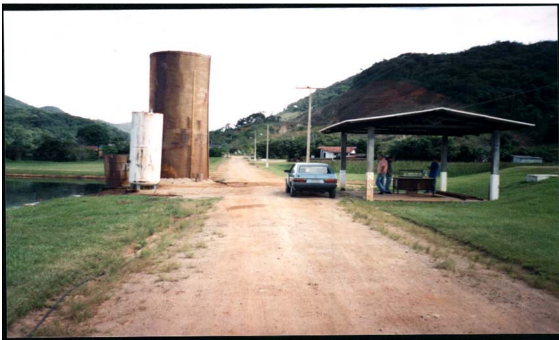
FIGURA 20 – GALPÃO DA CAIXA DE DOSAGEM DA SOLUÇÃO DE CLORETO FÉRRICO ONDE REALIZA-SE “JAR TEST”, TANQUE DE ARMAZENAMENTO E ESTOCAGEM E TANQUE DE DOSAGEM DA SOLUÇÃO DE CLORETO FÉRRICO.
