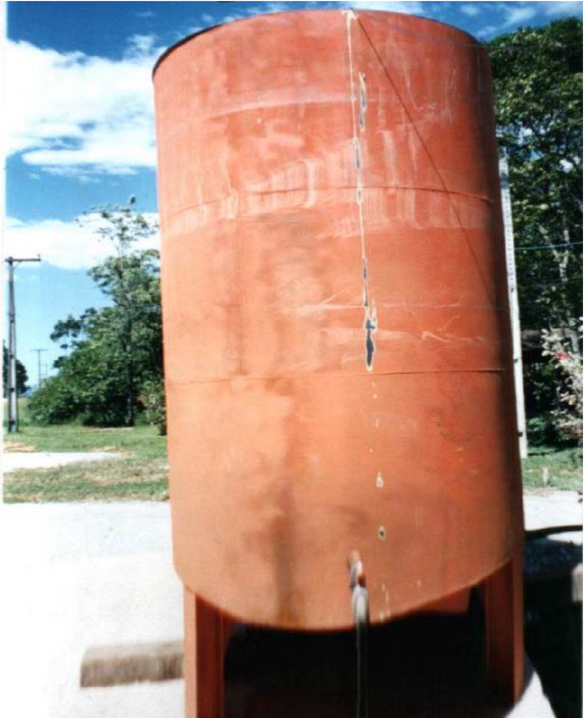
FIGURA 3: DEPÓSITO DE SOLUÇÃO DE NaOH UTILIZADA PARA ATENUAÇÃO DE ODOR NAS LAGOAS ANAERÓBIAS DO STE DA SEDE DO MUNICÍPIO DE JOINVILLE, SC. (10/12/99)
