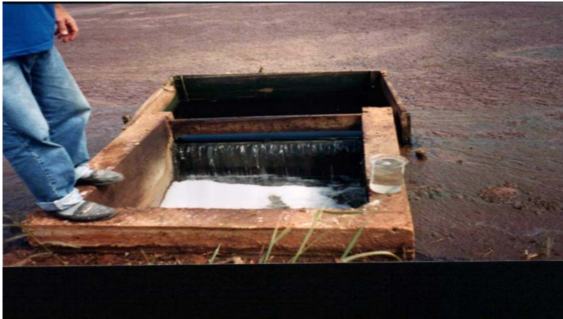
FIGURA 23 –EFLUENTE CLARIFICADO NA (LF-E) OU (L-L), COLETADO NA (CE-8.1) E SOBRENADANTES.
