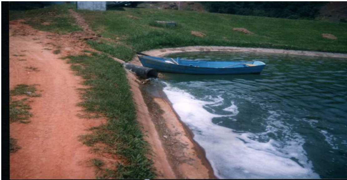
FIGURA 24 – EFLUENTE CLARIFICADO NA (LF-E) OU (L-L), SENDO CONDUZIDO ATRAVÉS DA (CE-1) PARA A (LF-1) E SOBRENADANTES.
