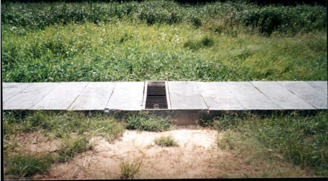
FIGURA 29 – (PV-3) RECEBE OS EFLUENTES DAS (LF-1 E LF-2) E ONDE, QUANDO NECESSÁRIO É DOSADO O ANTI-ESPUMANTE.
