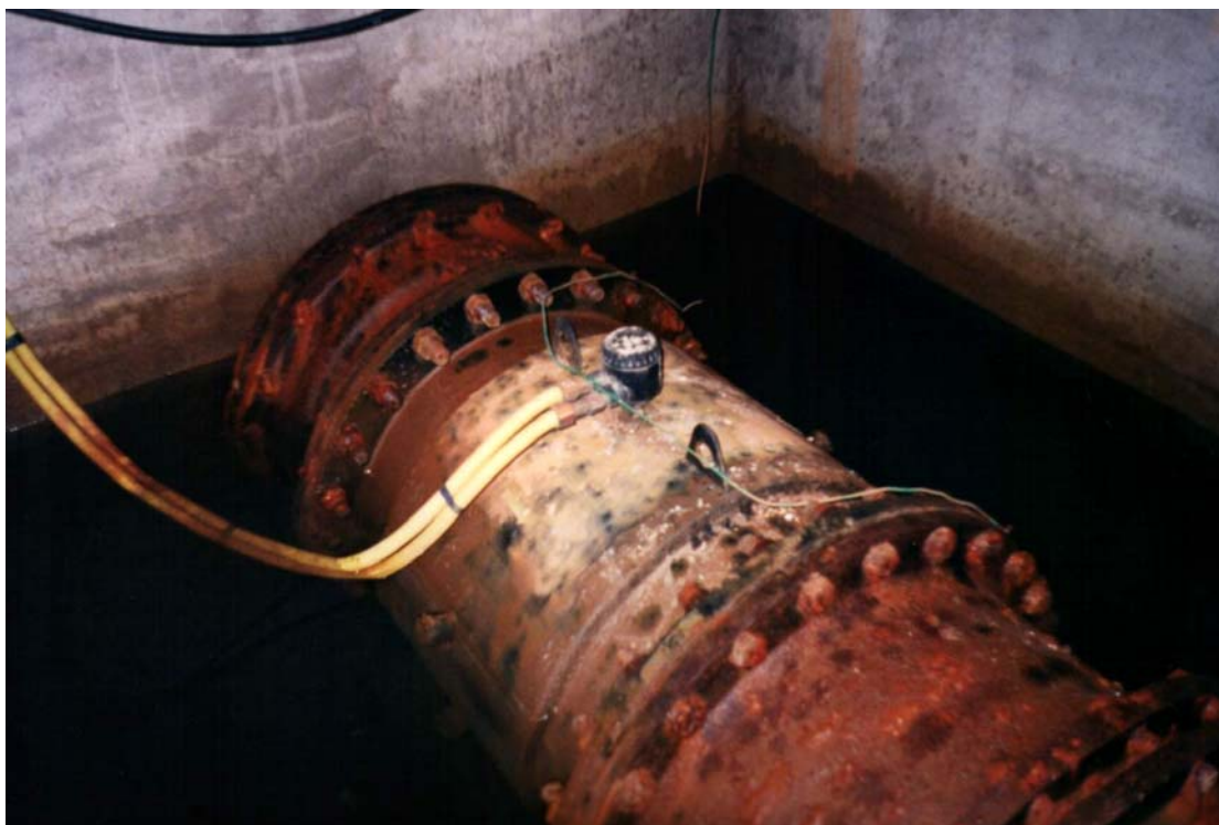
FIGURA 11 – MACROMEDIDOR ELETROMAGNÉTICO.
