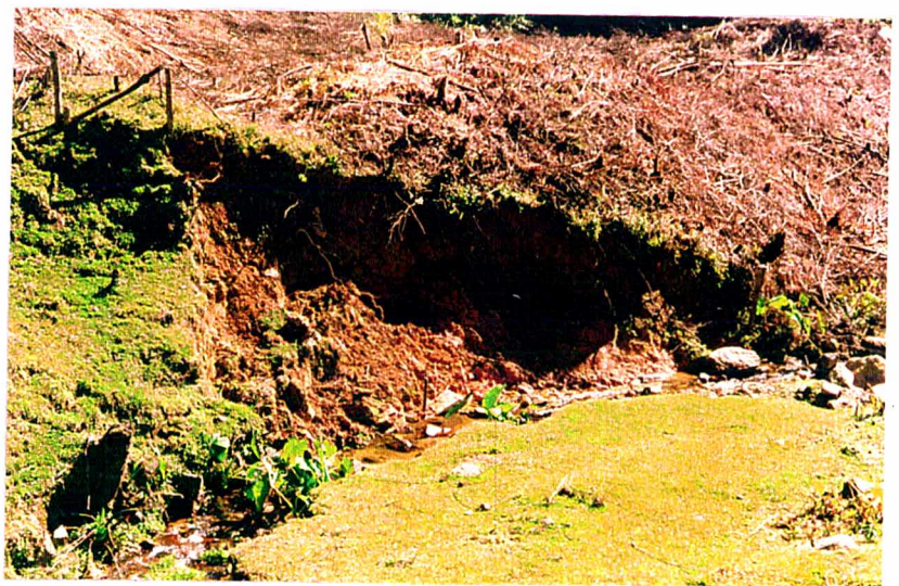
EROSÃO EM ARROIOS (FALTA DE MATA CILIAR)
