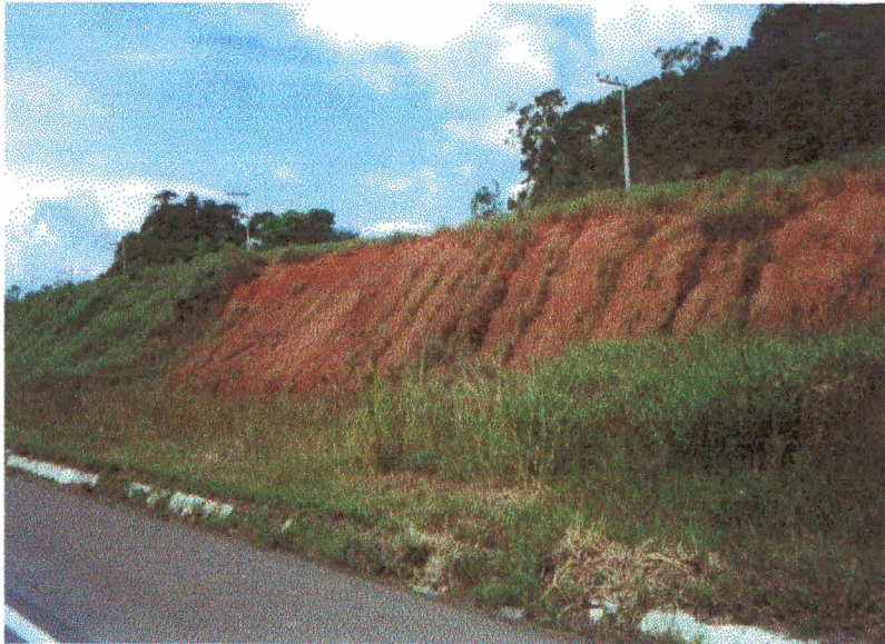
FIGURA 4.1 - Erosão em sulco (BR-470/SC)
