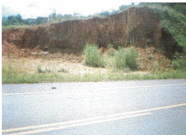
FIGURA 7.9 – Exploração predatória Falta de recuperação
