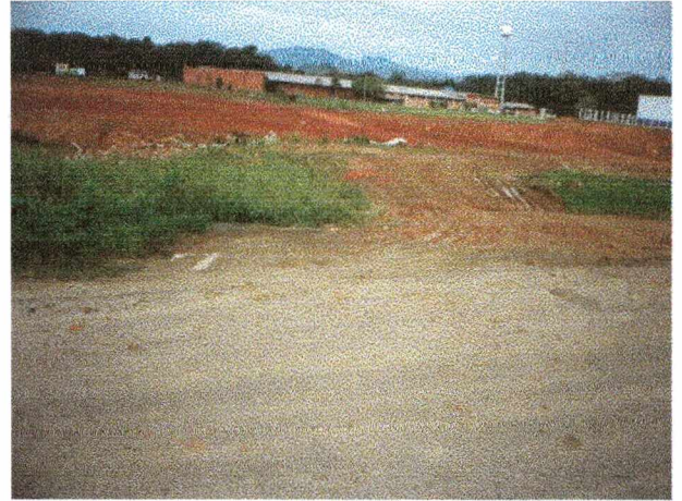
FIGURA 7.20 – Ausência no controle do uso do solo / Acesso irregular
