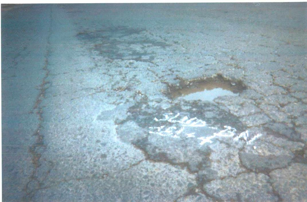
**Figura 6.8 – Panela formada e trincamentos interligados de severidade alta, parcialmente tratadas com execução de sela-trincas (km 181 +400)**
