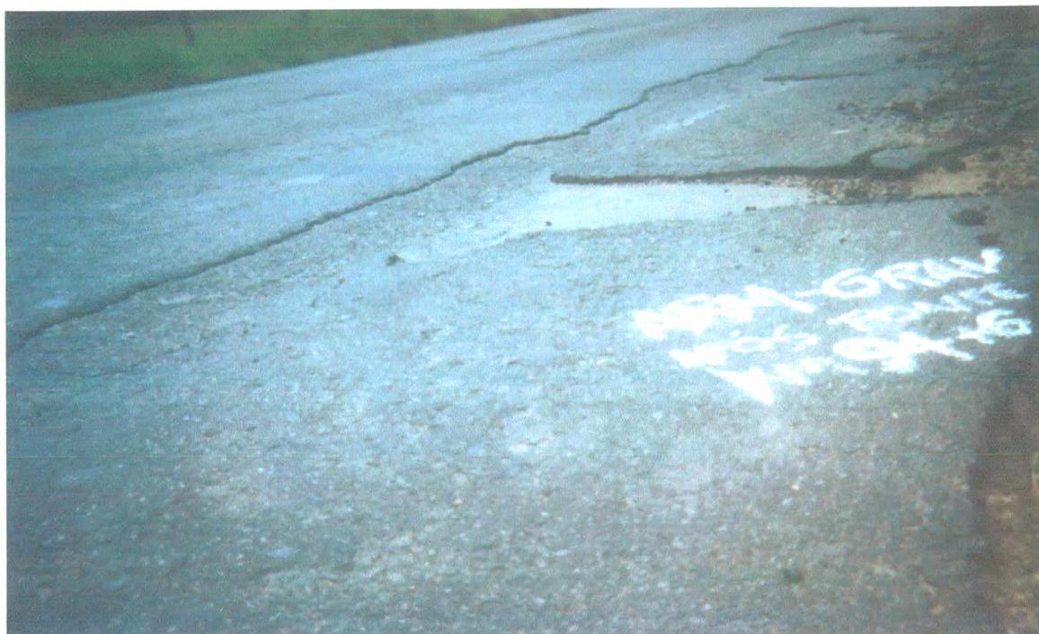
**Figura 6.4 – Remendos superficiais mal executados apresentando desagregações e arrancamentos no revestimento (km 104+300)**
