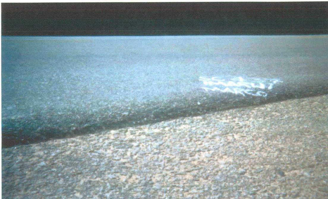
**Figura 6.14 – Acréscimo de espessura de concreto asfáltico proporcionado pela restauração efetuada no pavimento ( km 26 +630)**
