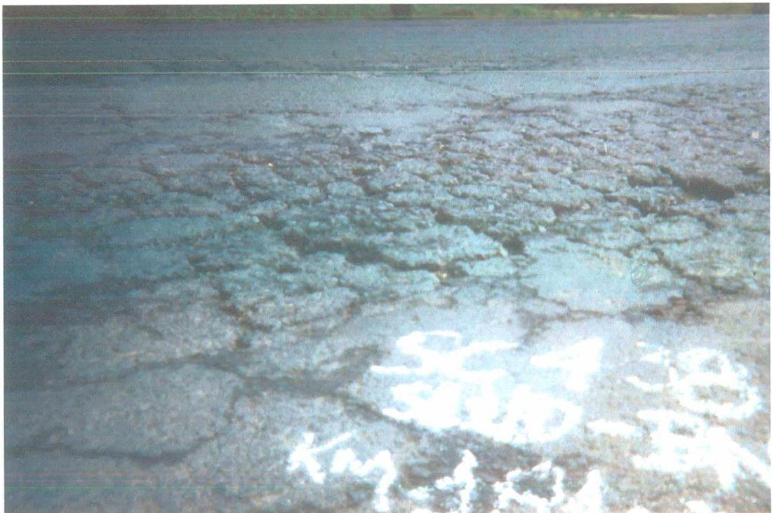
**Figura 6.7 – Trincamentos interligados de severidade alta, parcialmente selados com massa asfáltica fina, e apresentando o início formação de pancas ( km 181+320)**
