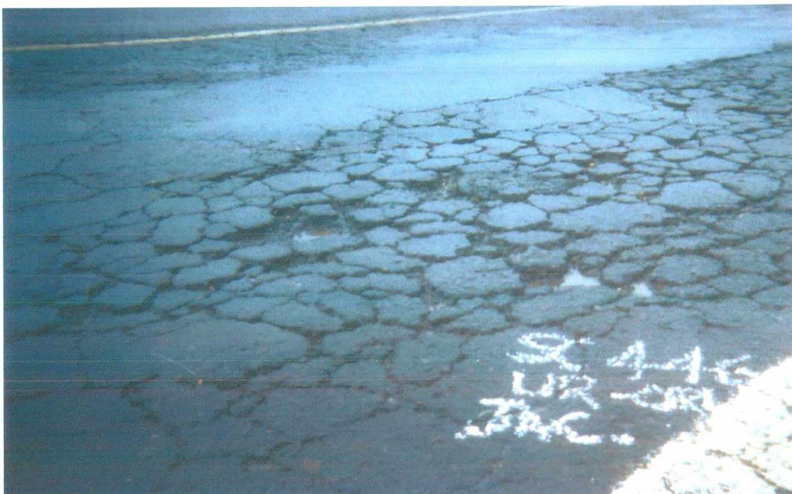
**Figura 6.10 – Trincas interligadas de severidade alta e processo de formação de painelas**
