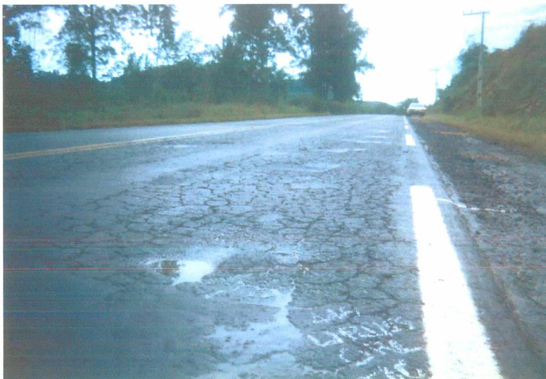
**Figura 6.11 - Trincas interligadas de severidade alta e afundamentos plásticos visíveis**
