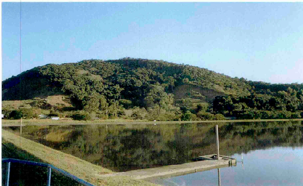
Figura 4: Vista Parcial da Lagoa Facultativa 1
