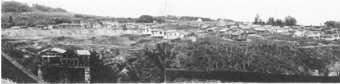
Vista parcial da Vila Operária: a boca da mina em primeiro plano. Ano:1942.
