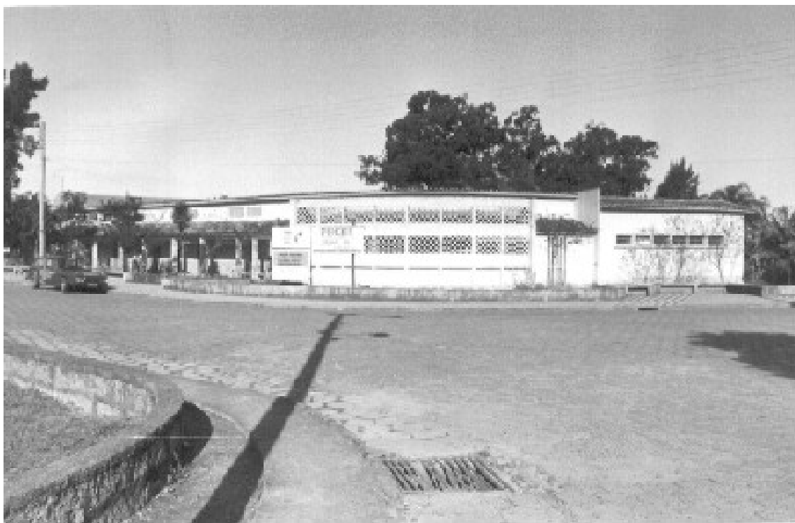
B. Próspera-Posto de saúde - Construído no período da CEPCAN - Década de 1960.
