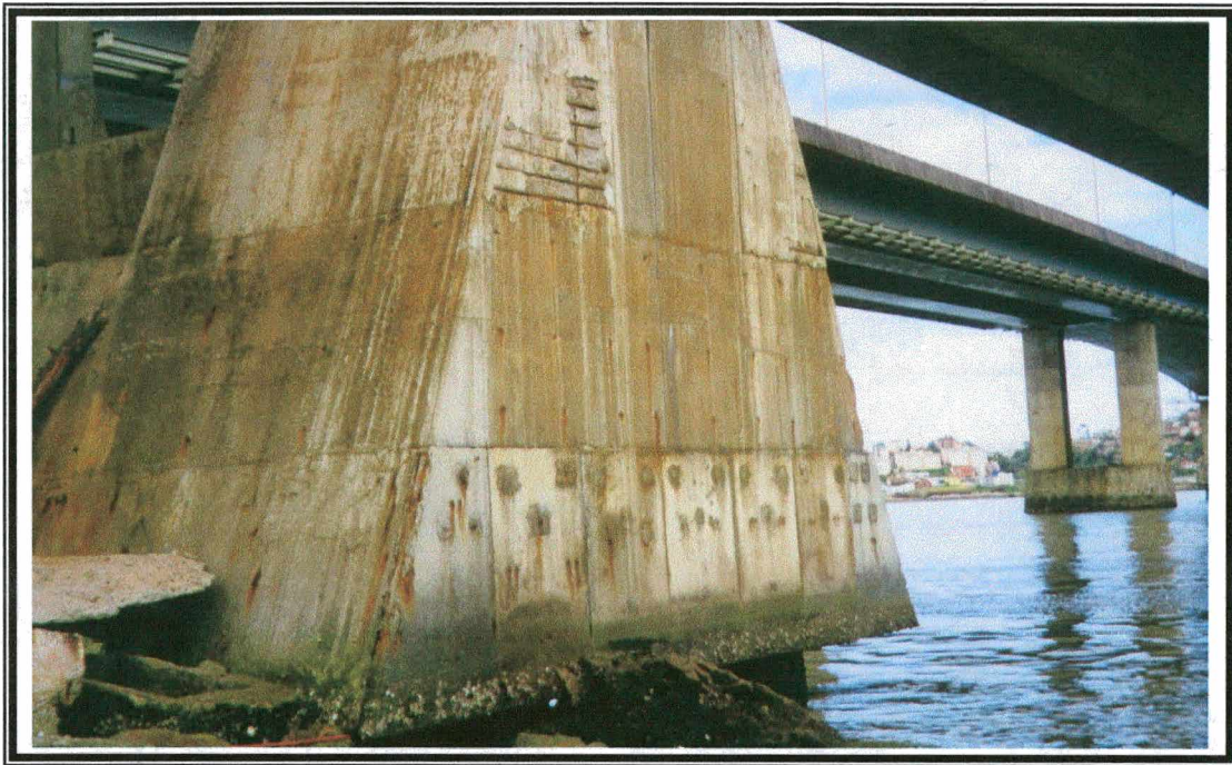
Figura 3.13 - Local de retirada de amostras do pilar sul, face sul.
