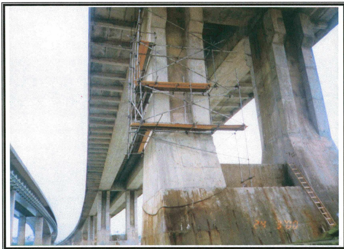
Figura 3.9 – Vista frontal do apoio 10, com andaimes no pilar sul, face sul.
