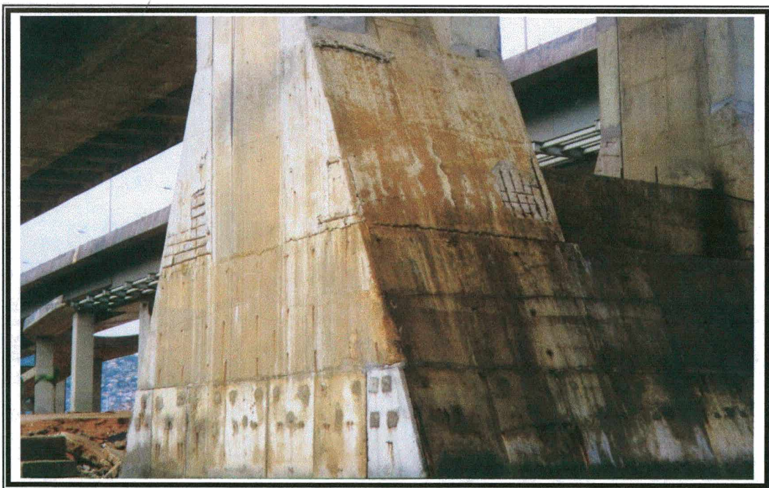
Figura 3.14 - Local de retirada de amostras do pilar norte, face norte.
