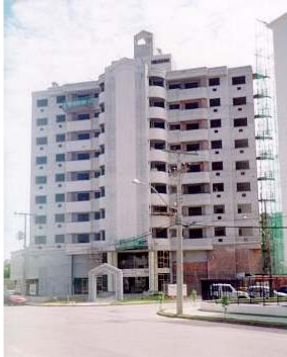
FIGURA 4.3: Imagem da obra durante sua execução.
