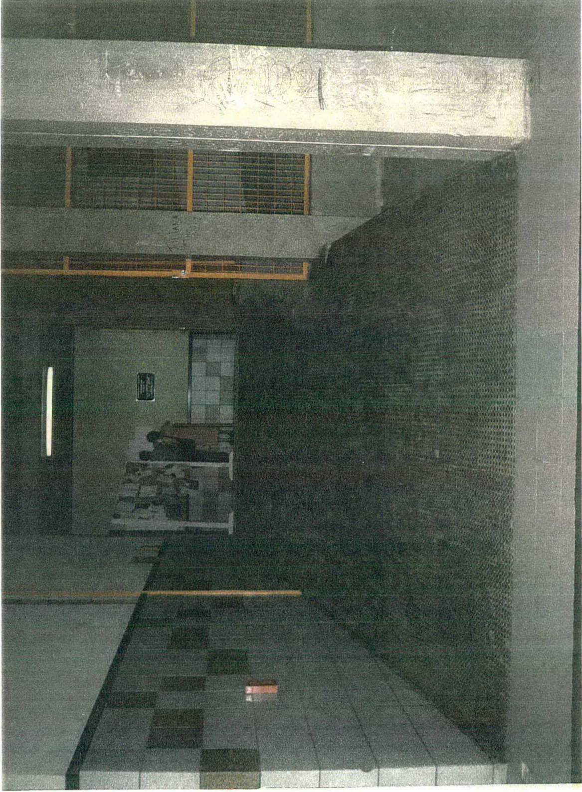
Foto IV - Rampa interna que dá acesso ao auditório da escola.
