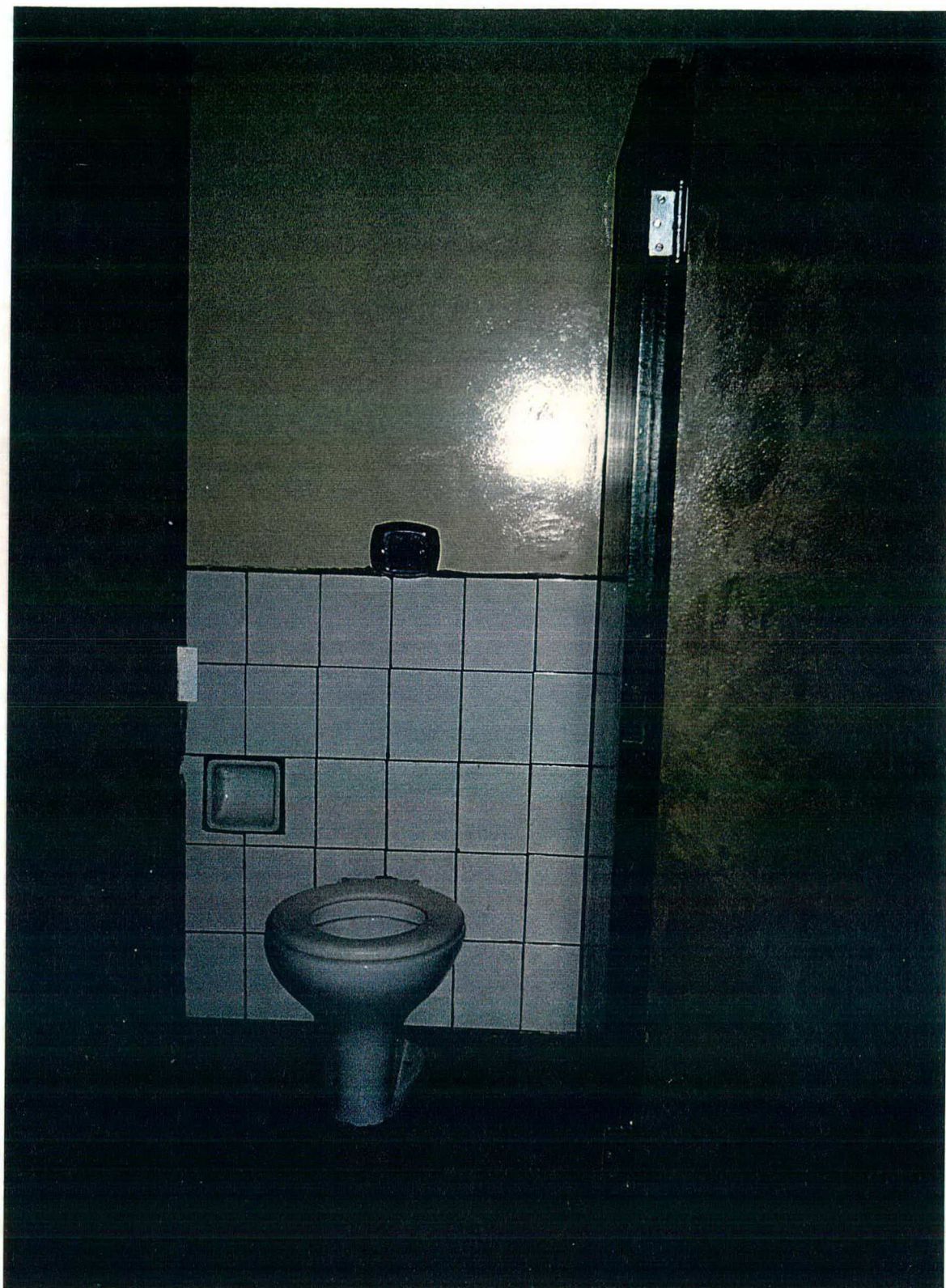
Foto VIII - Visão interna do espaço físico onde situa-se cada um dos vasos sanitários.
