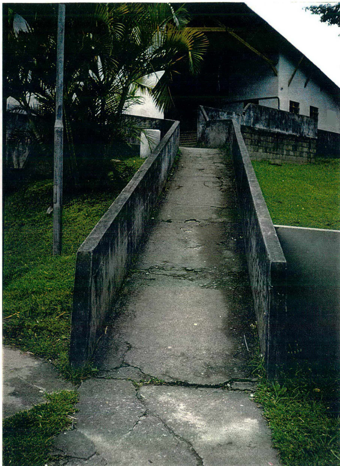
Foto V - Rampa externa que dá acesso à biblioteca da escola.
