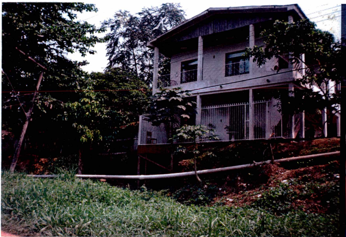
FOTO 9 - Residência na Rua Rio Grande do Sul em risco de desabamento. Notar a inclinação do poste no canto esquerdo - Nov/95
