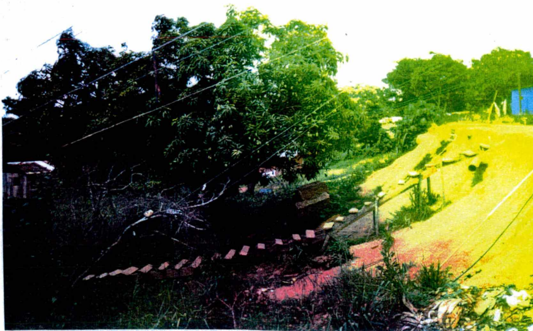
FOTO 5 - Trecho da Rua Gabino Besouro - Bairro do Preventório - afetado por ecorregamentos rotacionais - Nov/95
