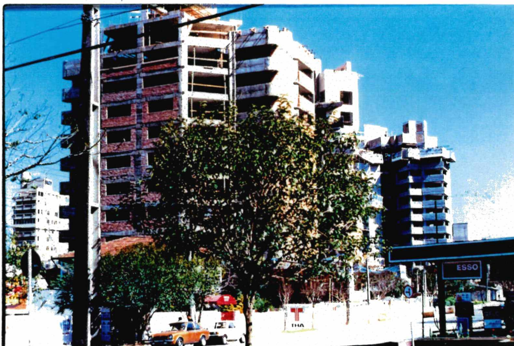
Figura 23 - Aglomerado de edificações que se utilizaram da lei do "solo criado". Apesar do respeito às disposições de recuo, a paisagem mostra-se bloqueada, baixando a qualidade visual e de vida da região.
