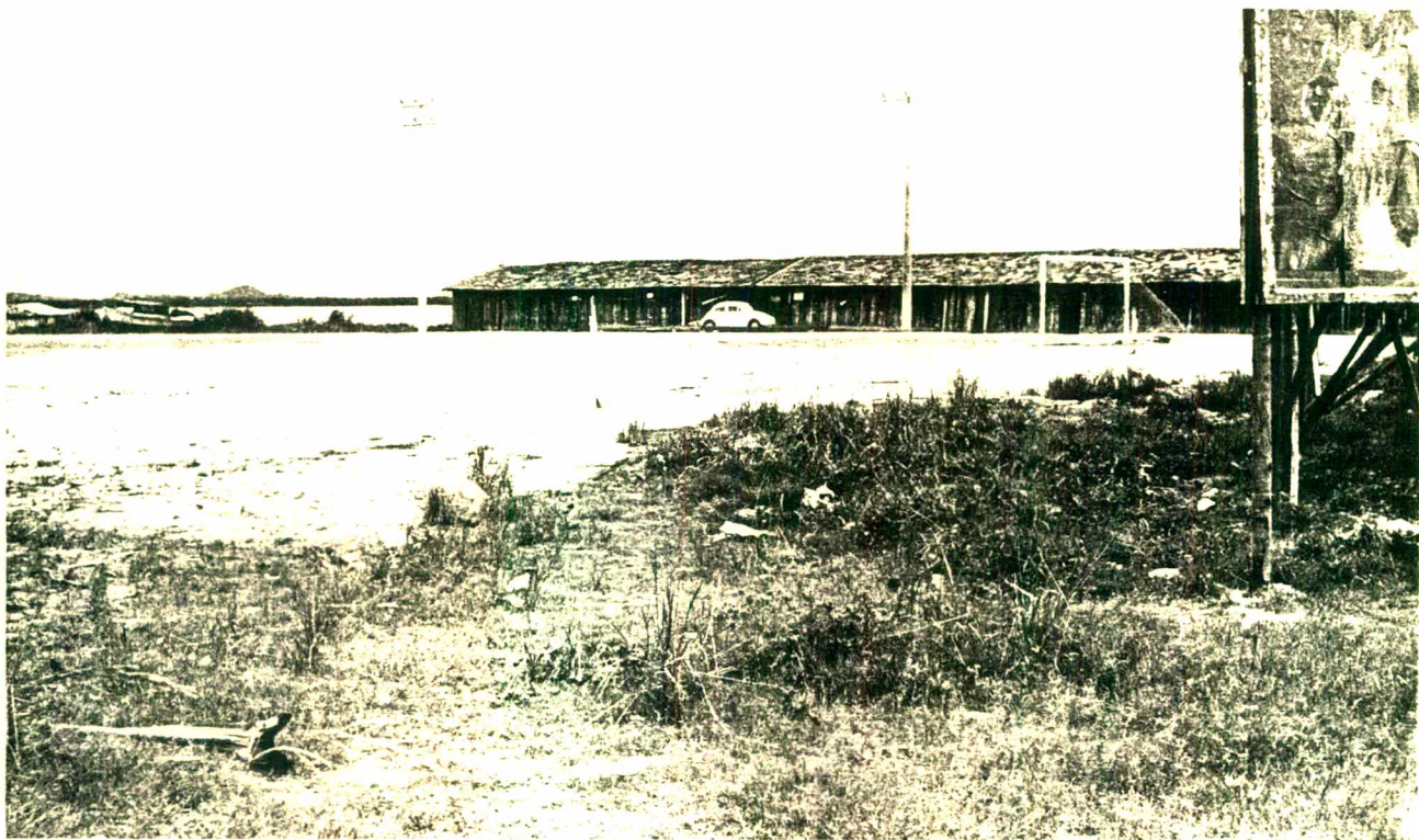
FOTO Nº5 - SACO DOS LIMÕES: aterro existente na Costeira do Pirajubaé.
