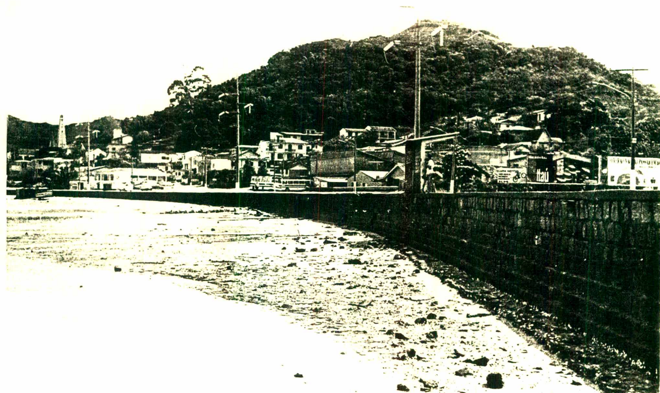
FOTO Nº3 - SACO DOS LIMÕES: muro de arrimo que sustenta o leito da via a beira-mar.
