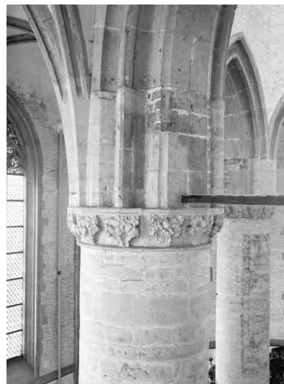
De kapitelen in het koor van de Pieterskerk in Leiden zijn rond 1390-1415 gebouwd. De slordige aansluiting van de bogen op de zuilen wordt door de dekplaat enigszins gecamoufleerd, maar laat zien hoe de coördinatie van planning en bouw in de praktijk soms om noodoplossingen vroeg.
