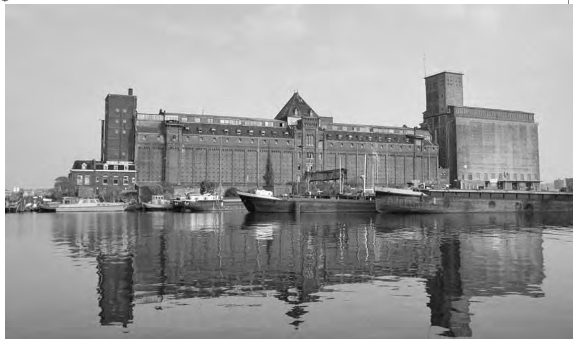
Graansilo Korthals Altes te Amsterdam is in 1898 ontworpen door architect J.F. Klinkhamer. De foto uit 1994 toont de toestand van voor de verbouwing tot appartementencomplex in 2000.
