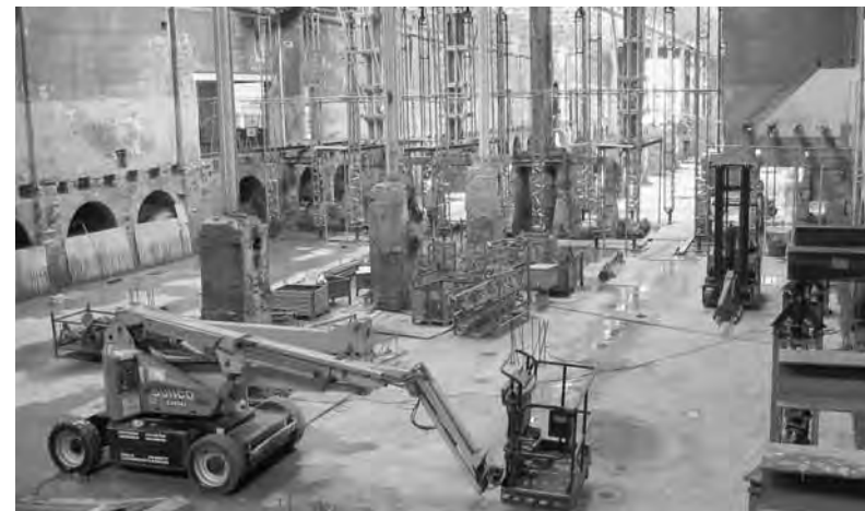
De Hallen in Amsterdam wordt vaak aangehaald als voorbeeld van een geslaagde herbestemming nieuwe stijl. De herontwikkeling van de voormalige tramremise en -werkplaats werd, na jaren van mislukte planvorming, gerealiseerd dankzij een betrokken groep van potentiële gebruikers.
