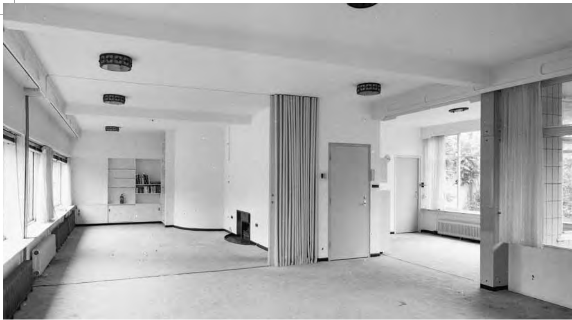
Het interieur van de huiskamer op de eerste verdieping van Huis Sonneveld te Rotterdam in 1999, voor de restauratie.
