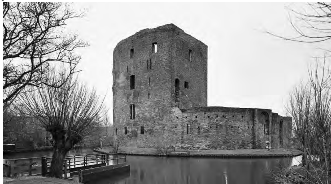
De ruïne van slot Teylingen in Sassenheim werd na een verwoesting in 1574 deels hersteld in de zeventiende eeuw, maar raakte vanaf 1795 door leegstand in verval. De ringburcht werd al in 1803 tot monument verklaard (foto 1993).
