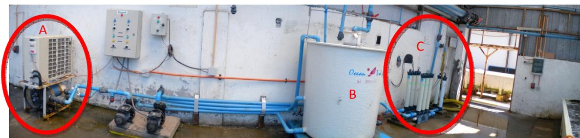
Figura 4: Tratamento de água para laboratório de reprodução e desova: (a) bomba de calor, (b) reservatório, (c) filtros de cartucho de 10, 5 e 1 $\mu$ m e UV.
