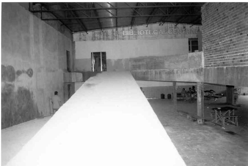
Figura 40: Reforma do Prédio da BC - Rampa interna de acesso ao piso superior 1995/1996
