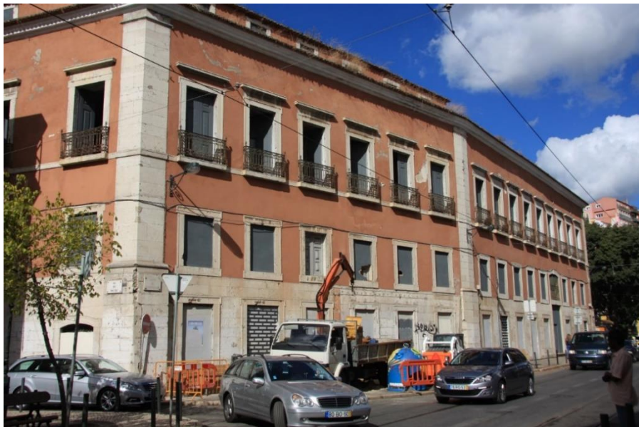
Figura 6: Vista Sul do Palácio Conde-Barão do Alvito, em Santos, Lisboa.
