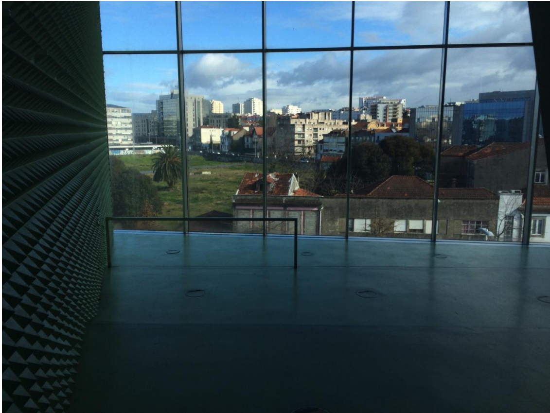
Figura 30: Cibermúsica, detalhe da parede em vidro e do revestimento
