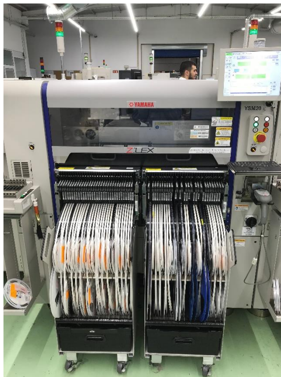
Figura 19: Linha de produção – Equipamento de montagem
