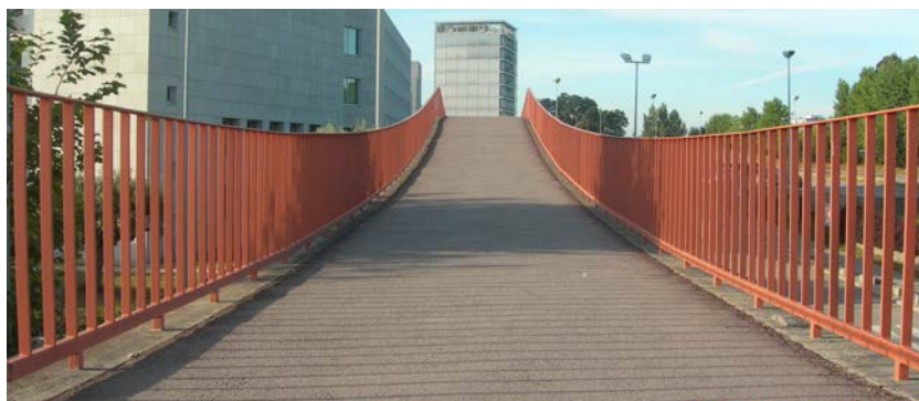
(d) Upper view of the deck
