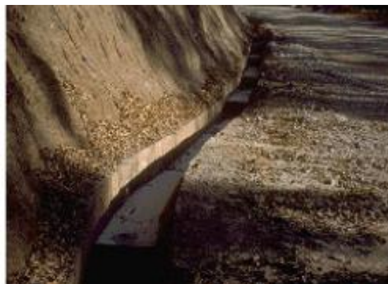
Figura 6 – Vala em betão para recolha e condução de águas superficiais.
