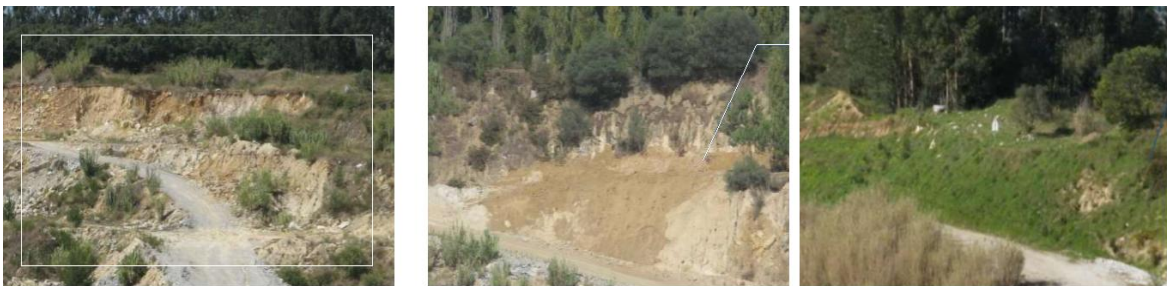
Figura 26 – Exemplificação da revegetação de taludes. Fonte: Secil
