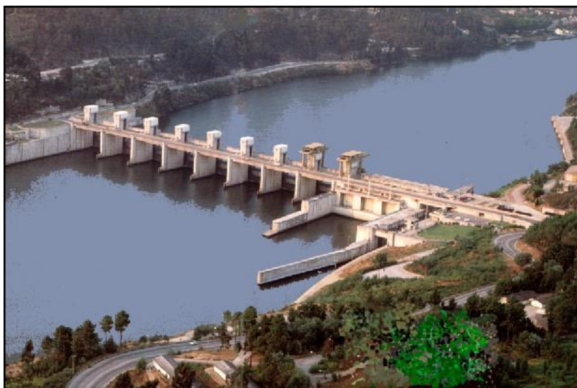
Figura 7. Vista Geral da Barragem e da albufeira de Crestuma-Lever (Fonte: http://www.wikienergia.pt/~edp/index.php?title=Imagem:CCL_VistaGerall.jpg ).
