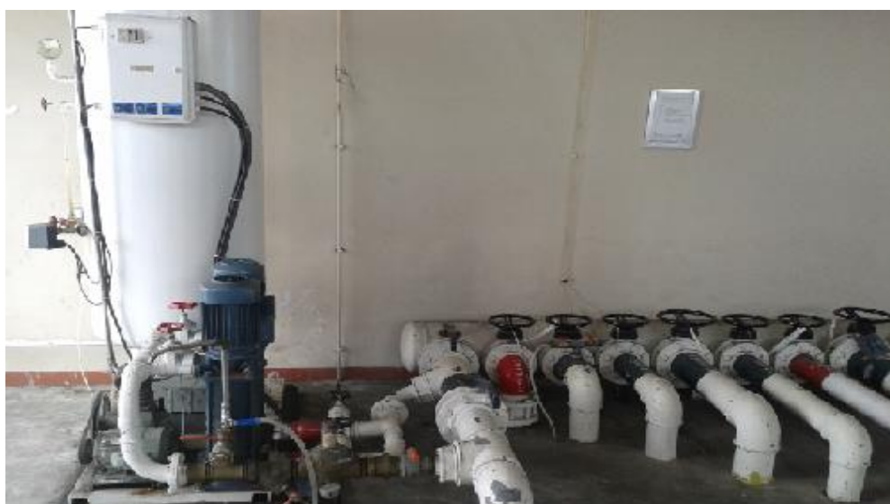
Figura 6.19 - Grupo hidropressor e circuitos de água.
