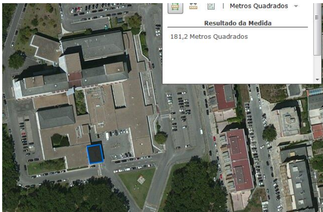
Figura 6.30 – Área considerada para possível colocação dos coletores solares 21 [63].
