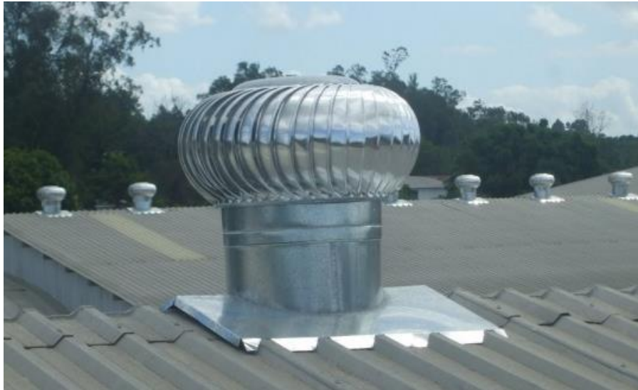
Figura 3.37 - Exemplo de aplicação de um exaustor eólico [47].
