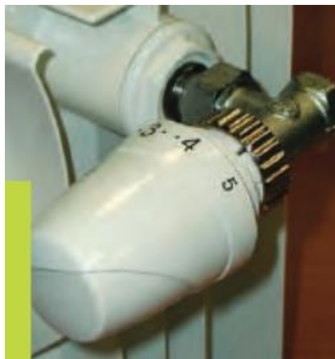
Figura 3.11 – Válvula Termostática [26].
