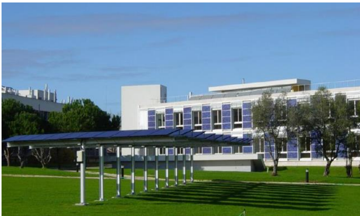
Figura 3.33 - Fachada do Edifício Solar XXI do Laboratório Nacional de Energia e Geologia [40].
