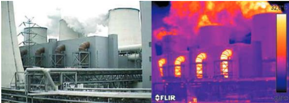
Figura 3.24 – Aplicação da termografia na indústria [37].
