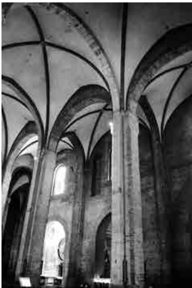
Fig. 10. Milano, Basilica di San Simpliciano, veduta delle navate verso sud-est con le volte costolonate di XIV secolo.
