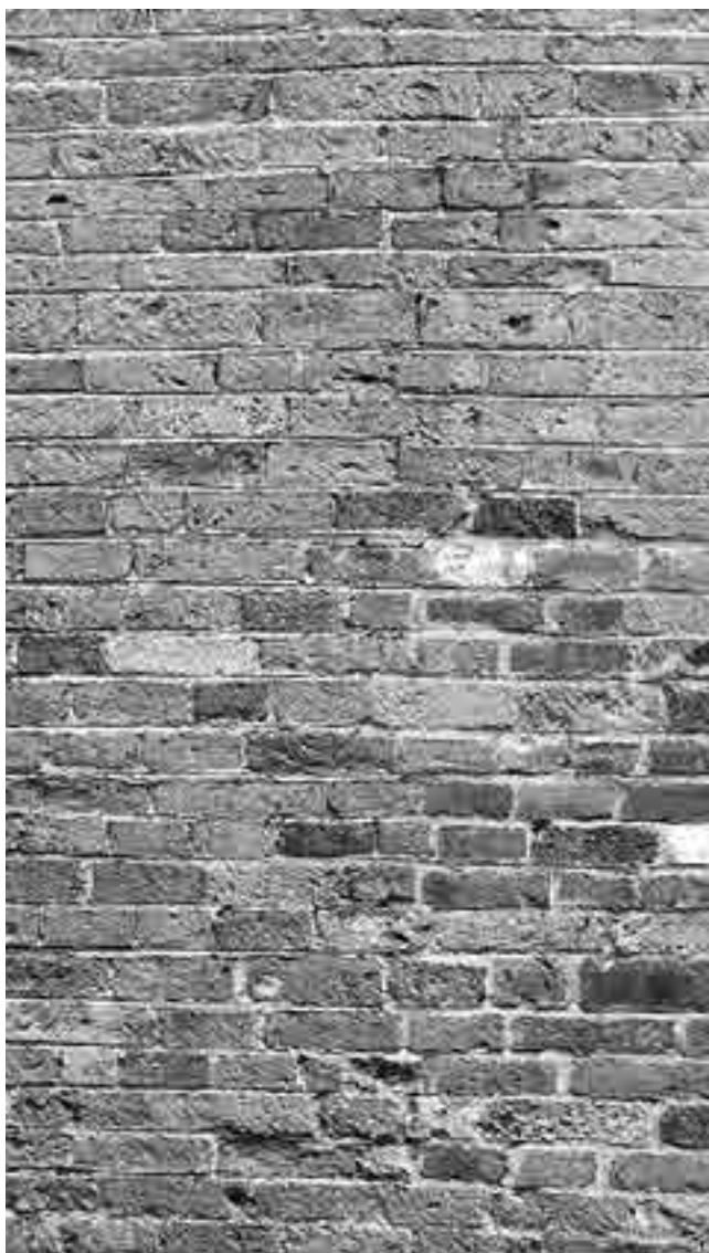
Fig. 8. Milano, Basilica di San Smpliciano , dettaglio della muratura dell'abside.
