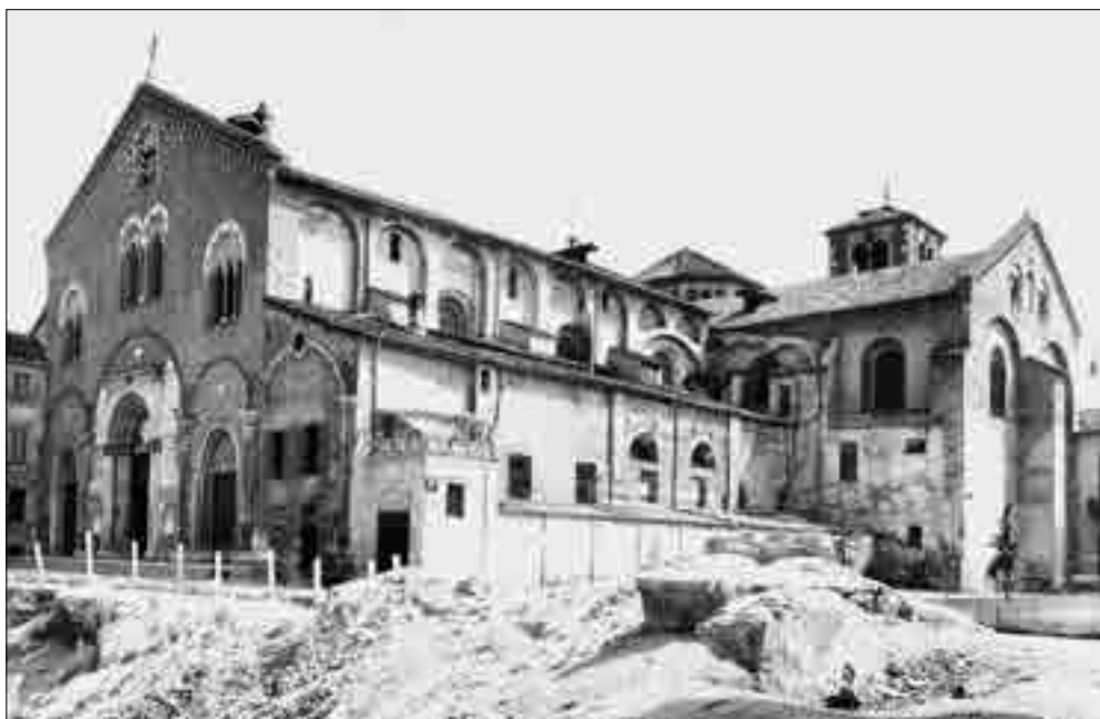
Fig. 1. Milano, Basilica di San Simpliciano all'epoca degli scavi di Mario Mirabella Roberti, 1960-1961, SABAPMi.
