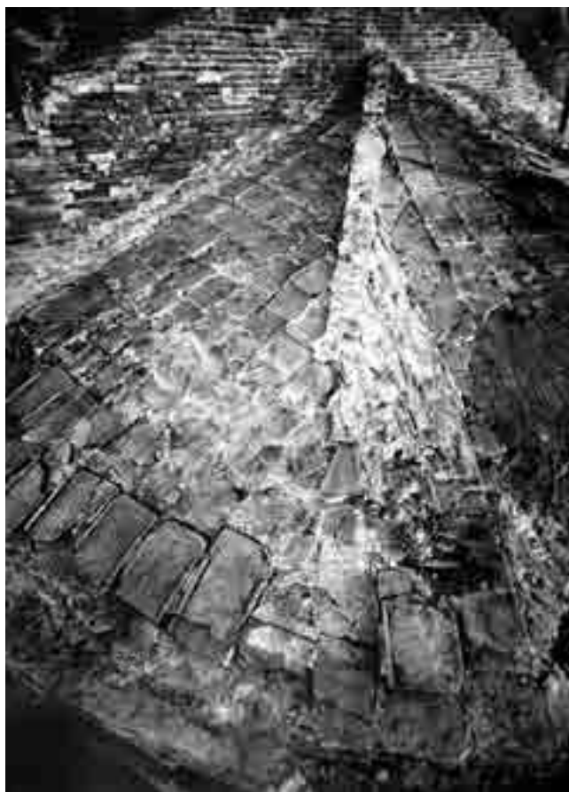
Fig. 7. Milano, Basilica di San Smpliciano, resti delle tegole e di intonaco romanici sopra la calotta absidale durante i restauri del maggio 1963, SABAPMi, Chiesa di S. Smpliciano, cass. 18, lavori 2.
