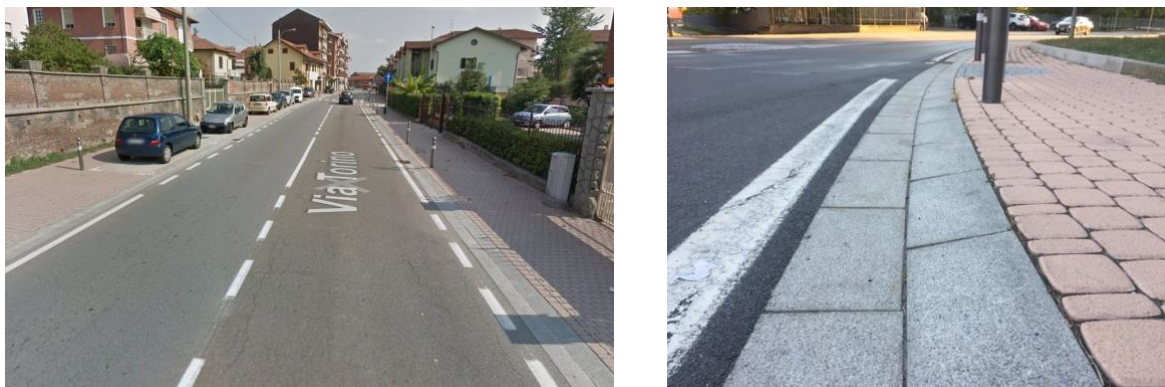
Figura 6. Marciapiede a limitata sopraelevazione con cordolo di raccordo e cunetta di scolo integrata. Oltre ad agevolare la pulizia, questo tipo di marciapiede può essere eccezionalmente utilizzato per la manovra di veicoli (ad esempio per aggirare un ostacolo presente sulla carreggiata) (Trofarello, TO, 44.9831° N, 7.7432° E; Immagine a sinistra tratta da Google StreetView, Google, Inc. 2018; Foto a destra F. Vidotto).
