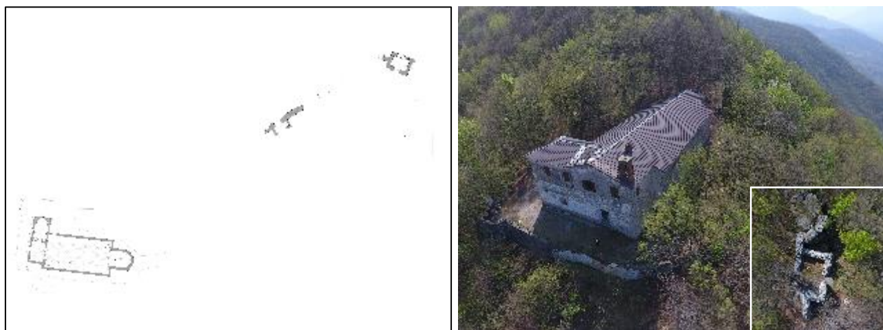
Figura 1 - A sinistra rilievo della posizione delle strutture emergenti; in basso il complesso religioso, poco oltre la metà della salita la porta e un tratto nel muro di fortificazione e sulla sommità la torre. Un ampio tratto del muro perimetrale risultava di difficile rilevamento vista l'asperità del terreno.
