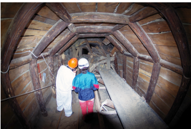
Fig. 2: the "Flottazione" tunnel during inspections of May 2014 (photo G. Badino). Fig. 2: fasi dell'ispezione del tunnel "Flottazione" nel maggio 2014 (foto G. Badino).
