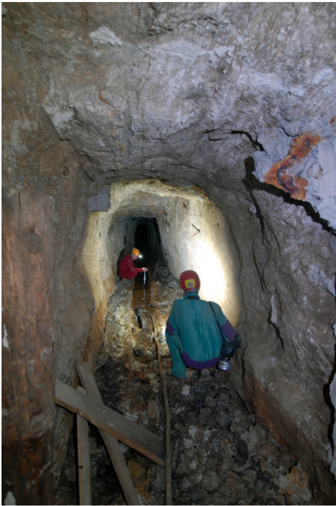
Fig. 11: air circulation analysis and topographic activities in the 3 rd level gallery (photo M. Vattano). Fig. 11: fasi di analisi della circolazione dell'aria e di rilievo topografico nella galleria del 3° livello (foto M. Vattano).
