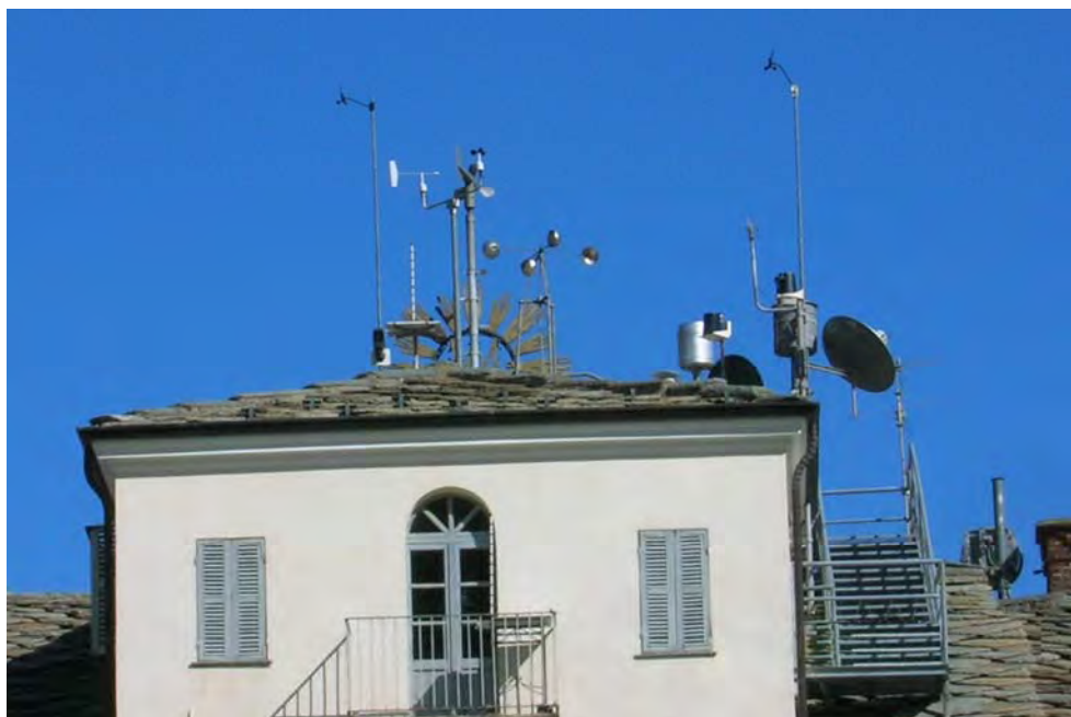
Figura 2.39 – Stazioni meteorologiche di Oropa: sul tetto a destra, gli strumenti ex-SIMN, a sinistra i sensori di ARPA Piemonte (foto: S. Fratianni).
