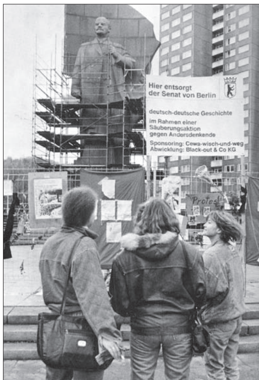
Image 1. Lenin-Denkmal before the demolition, Friedrichshain, 4 November 1991. Photo by W. Mrotzkowski, in B. Kramer, ed., Demontage... Revolutionärer oder restaurativer Bildersturm? (Berlin: Kramer Verlag, 1992), p. 52.
