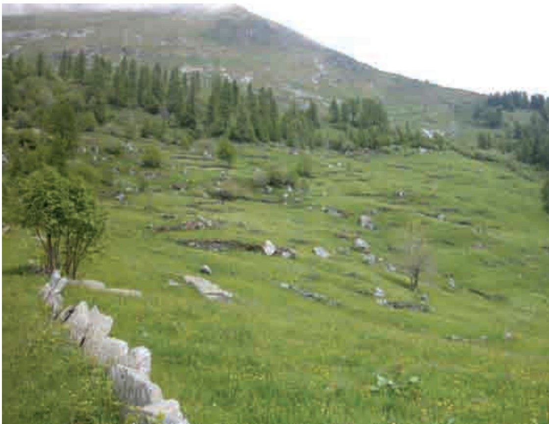
Figura 5. Sistemazione a gradoni con tratti di muretto a secco raccordati al pendio
