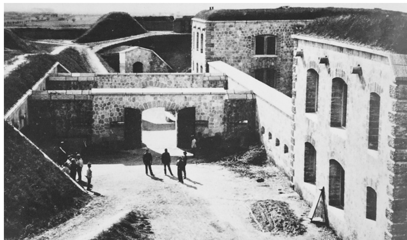
Fig. 84 Forte Prinz Rudolph. Il retro del ridotto centrale in una fotografia del 1866. Fonte "La piazzaforte di Verona sotto la dominazione austriaca 1814-1866 Jacobacci V., 1980"
