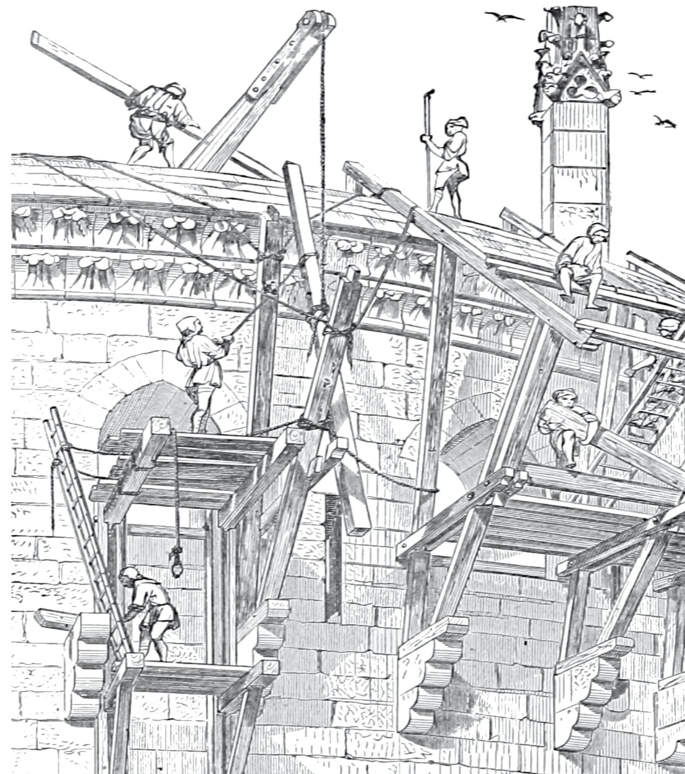
Fig. 46 La fase finale della costruzione delle fortificazioni esterne da parte dei falegnami. Non era necessario armare una fortificazione molto prima della venuta del nemico in quanto c'era la possibilità che la struttura venisse incendiata vista l'enorme quantità di legno presente, andando a causare ingenti danni all'assedato.
