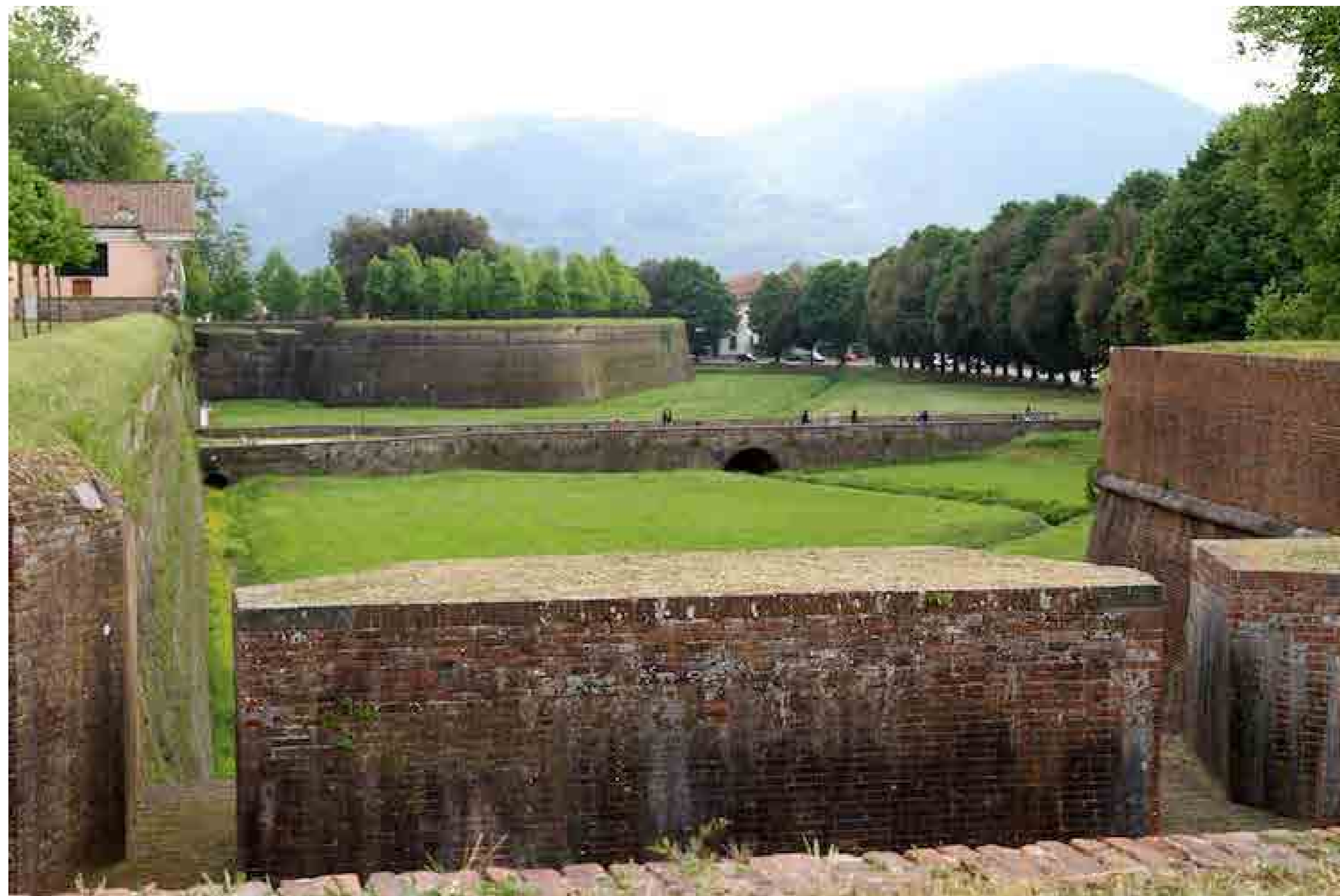
Fig. 159 Veduta tra un baluardo settecentesco e l'altro delle mura lucchesi.
