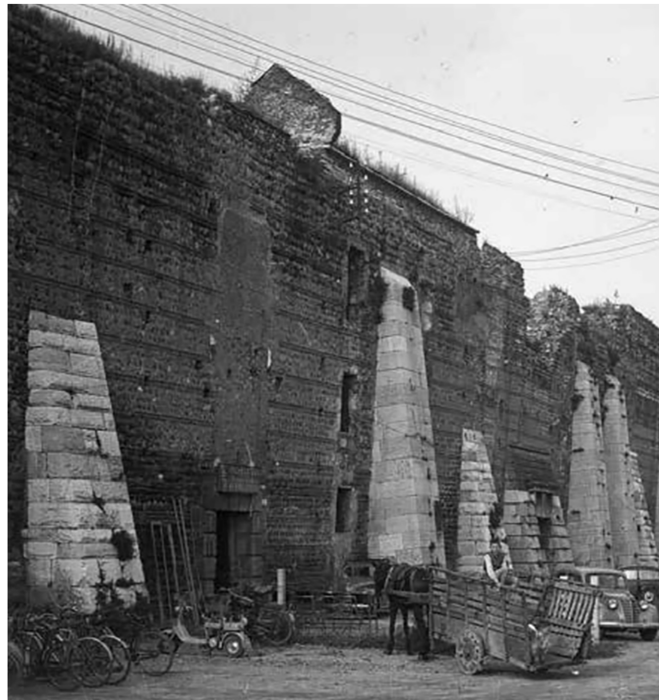
Fig. 23 Le cortine murarie viscontee conservate tra la Gran Guardia e l'Adige (tratto della Cittadella) sono state più volte rimaneggiate, adattate alle rinnovate destinazioni degli edifici tra di esse costruiti, trapassate e interrotte da un nuovo fornice (verso stradone Maffei) e da una breccia (lungadige Capuleti). Nulla rimane delle porte medievali (Porta della Paglia e Porta Rofiolana), in seguito all'allargamento dei fornici. Veduta da via Pallone
