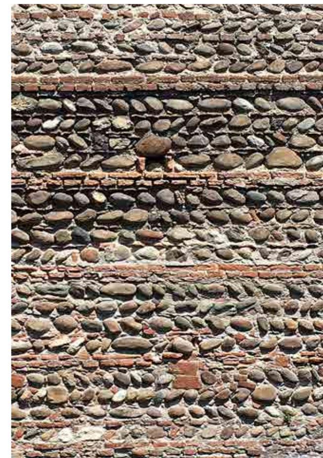
Fig. 26 (sopra) Vista di Castelvecchio, originariamente chiamato Castello di San Martino in Aquaro, dall'altra sponda dell'Adige. (sotto) Stratificazione classica delle mura scaligere con strati di mattoni, intervallati dal ciottolame ricavato dal letto dell'Adige, a mantenere l'asse orizzontale.
