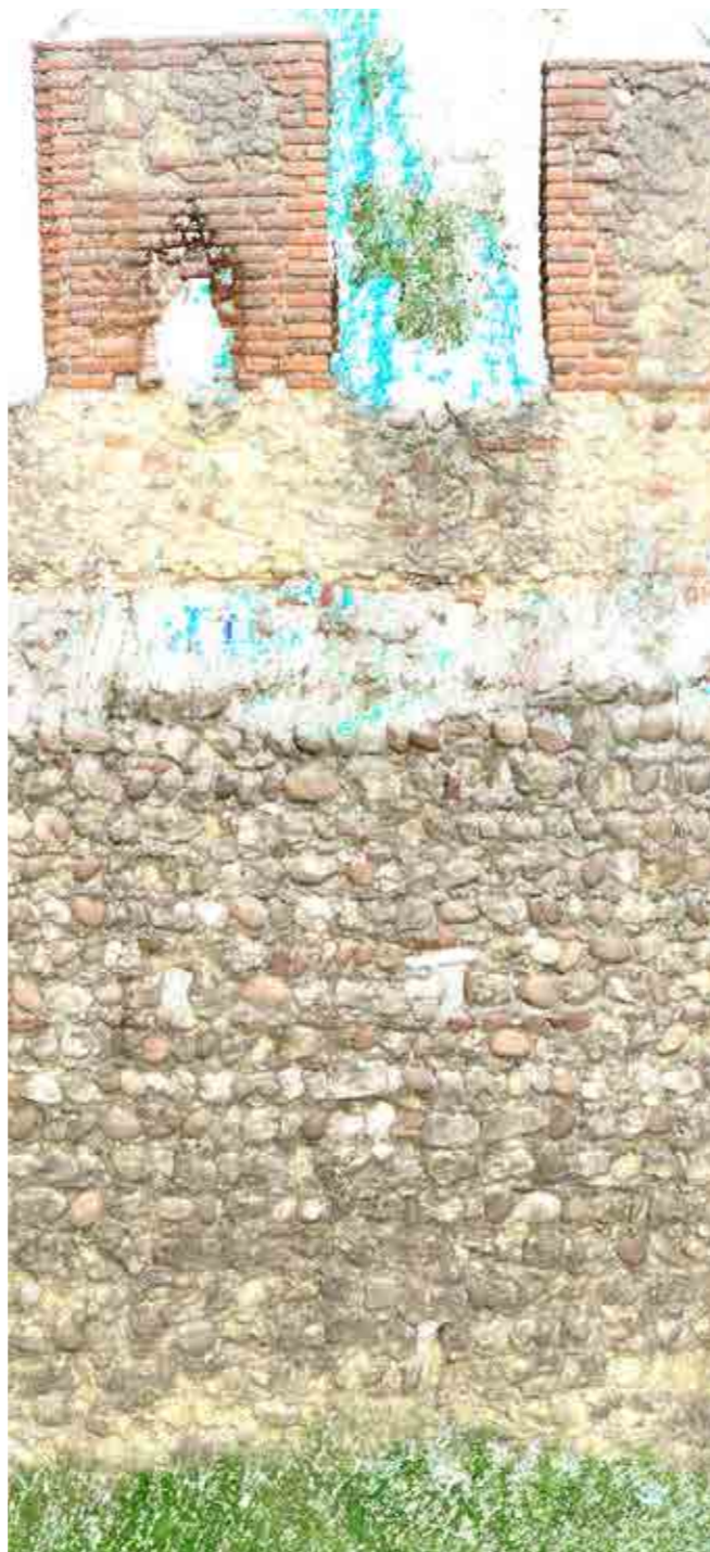
Fig. 107 Porzione di nuvola di punti colorata ottenuta da un FARO scan cam2 sul percorso denominato Cammino di Cangrande nella riva sinistra del fiume Adige
