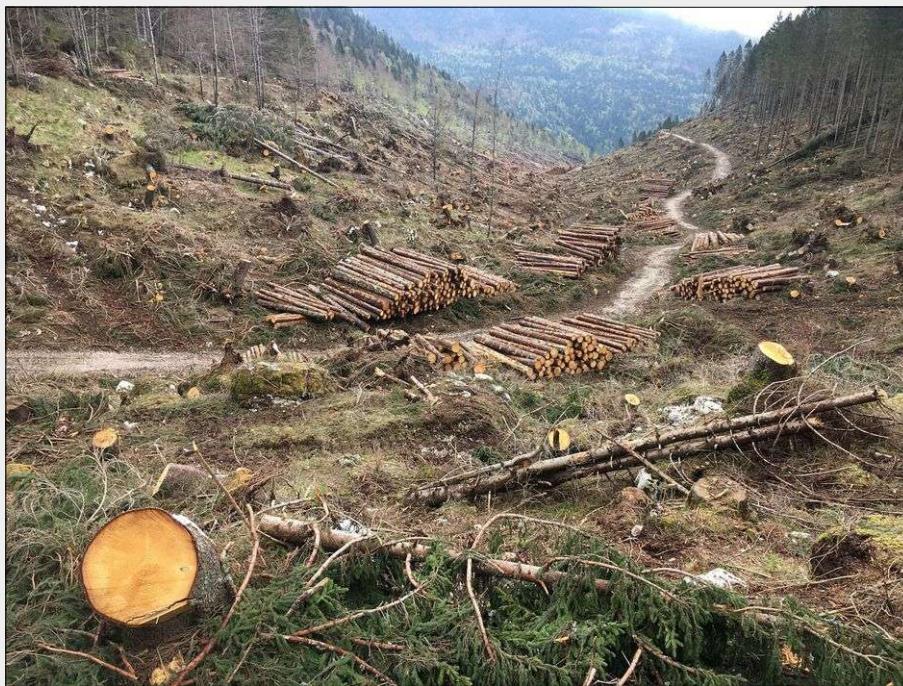
Fig. 1 - Strada forestale di recente costruzione (2017-2018) e prontamente utilizzata per il recupero del legname danneggiato a seguito della tempesta Vaia di fine ottobre 2018. La presenza della strada ha limitato di fatto la lunghezza delle piste forestali di esbosco, contenendo il fenomeno di erosione e il rischio compattamento del suolo (Altopiano dei Sette Comuni, Veneto).
