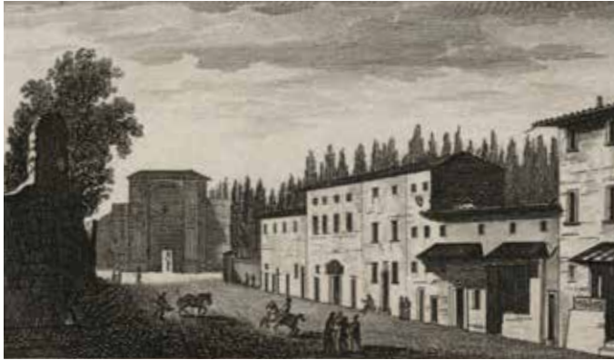
Fig. 39 ASCFi, Fondo Disegni, car. 367/009 Scuderie (ex) Reali "Reali Scuderie e Viale Machiavelli in costruzione" edilizia scolastica: Istituto Statale d'Arte Localizzazione: Firenze (Ita) — Porta Romana (piazze della) veduta d'insieme durante i lavori di costruzione. Iscrizione e timbri sul verso veduta, rilievo (1866-1870, attr.).
