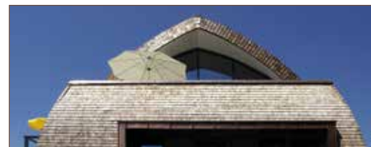
Realizzazione architettonica con copertura simile a uno scafo rovesciato, i cui componenti curvi sono di crosslam.
