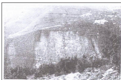
Fig. 3 - L'alluvione di Salerno (25 ottobre 1954) provocò sui Monti Lattari numerose frane classificabili come scorrimenti planari evoluti a colate detritiche. Il fenomeno interessò pendici a forte pendenza costituite da coltri piroclastiche ricoperte rocce carbonatiche, su cui erano radicati cedui castanili. Hofmann (1955), che a quel tempo dirigeva l'Ispettorato Ripartimentale delle Foreste di Salerno, formulò una diagnosi precisa del fenomeno di cui nessuno tenne conto per impedire il suo ripetersi in futuro. (Foto Hofmann).
