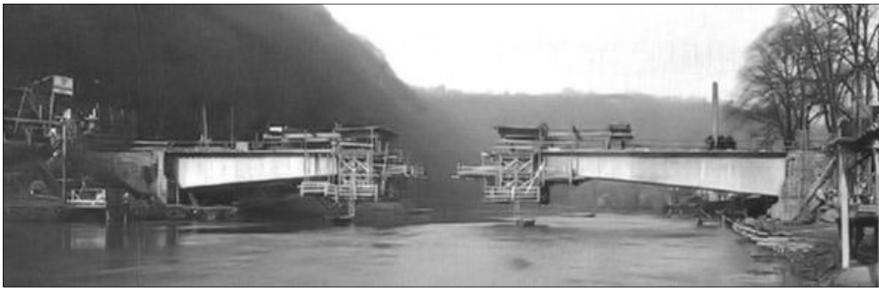
Fig. 3 - Ponte di Balduinstein ( L_{\text{tot}} 62.0 m) Fase di costruzione dei conci tramite casseri mobili. Trattandosi di un impalcato a campata unica le estremità laterali sono dotate di contrappeso per sostenere la costruzione a sbalzo (Troyano Fernández, 2006).
