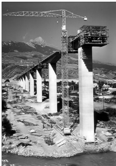
Figg. 4 e 5 - Il ponte di Savines, progettato da J. Courbon e realizzato dalla GTM in soli 20 mesi tra il 1958 e il 1960, è una delle prime e più importanti opere costruite in Francia ad avanzamento bilanciato. Le stampelle risultano tra loro incernierate. (Combault, 2007) ( www.savineslelac.com ).
