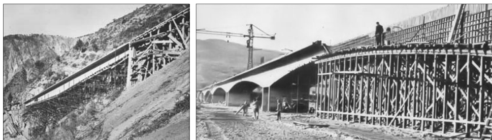
Figg. 6 e 7 - Ponte per l'impianto del Mucone ( L_{tot} 54.5 m, 8.5 + 37.5 + 8.5, l_{imp} 2.7, h_c 1.8 m, h_p 1.0 m, i_L 38.6%) in Calabria (I,1950) realizzato con sistema di precompressione Freyssinet (Zorzi, 1981) - Ponte sul fiume Bradano ( L_{tot} 357.0 m, 29.5 + 5 x 59.6 + 29.5, l_{imp} 8.8, h_c 1.0 m, h_p 3.0 m) (I,1957-58) con impalcato, realizzato con sistema di precompressione Morandi, caratterizzato da cerniere in mezzzeria ed incastrato su pile a doppia lama di bassa altezza. (Bologna & Maddalena, 1962)
