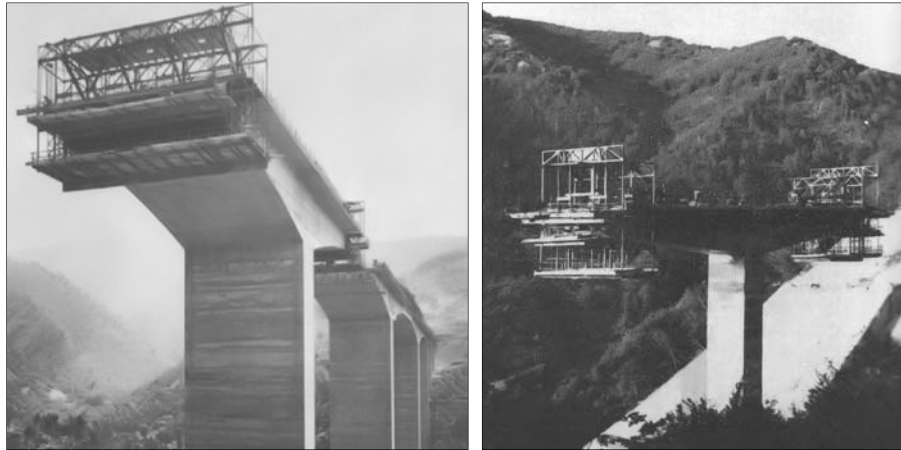
Figg. 10 e 11 - Ponti sul torrente Nervi (I,1964) (Zorzi, 1981) e sul torrente Cubia (I) (AICAP, 1997), rispettivamente opera di Zorzi e di Cestelli Guidi;
