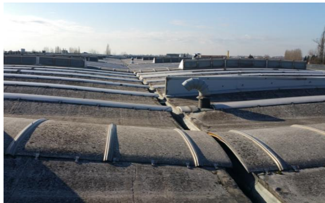
Figura 8. Vista della copertura - zona industriale.
