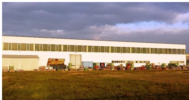
Figura 3. Vista lotto 1 (prospetto sud-est).
