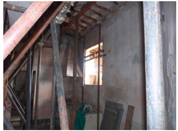
Figura 24: Puntellamenti sottostanti la copertura del palagio.
