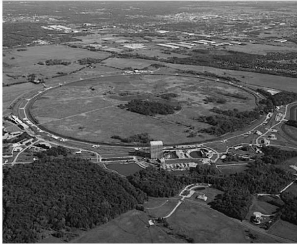
Fig. 4 – Il collisionatore TEVATRON al Fermilab.
