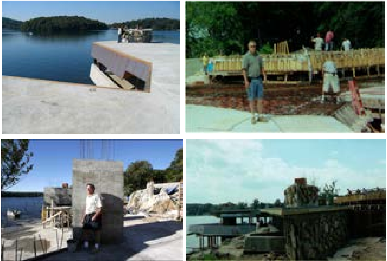
Figura 168: Fotografie di cantiere (T.A. Heinz)
