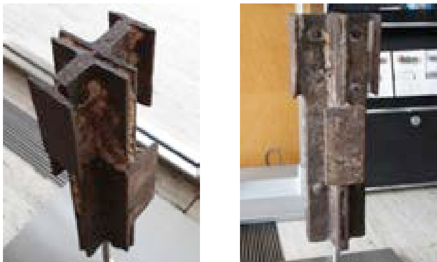
Figura 13: Il pilastro cruciforme ritrovato in fase di ristrutturazione 25
