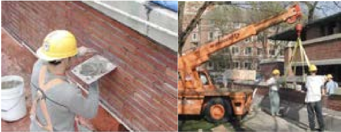
Figura 80: Il restauro del muro perimetrale a sud 115
