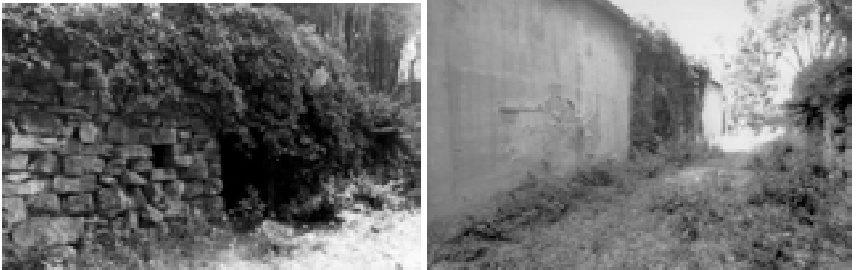
Figura 328 – Il deposito posteriore e la facciata posteriore della Limonaia – anni '70-'80 (AABS)
