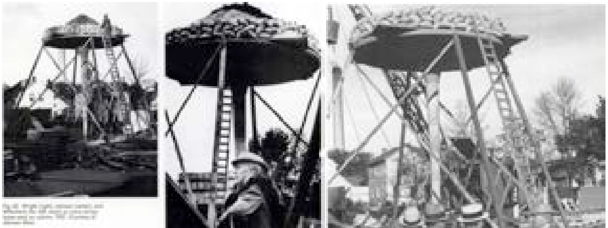
Figura 123: Il cantiere del Johnson Wax Building: Sono visibili le fasi di realizzazione del pilastro dendriforme. I sacchi di sabbia in sommità furono posizionati per il collaudo del pilastro. (1936) 175
