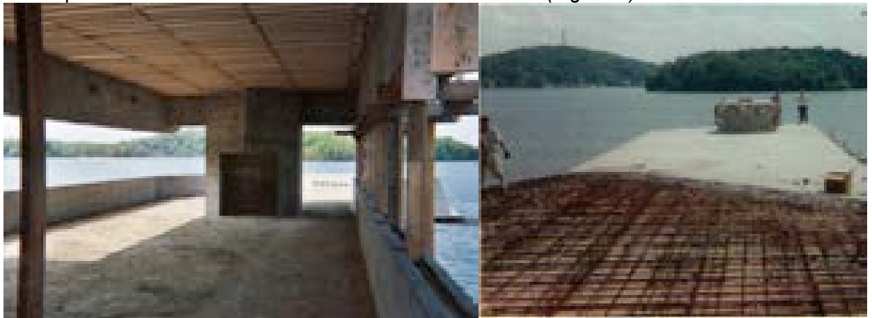
Figura 167: Fotografie di cantiere (T.A. Heinz)
