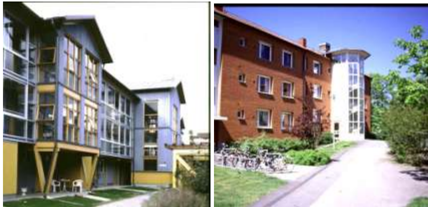
Fig. 5 Facciate con parti aggiunte per permettere l'inserimento di ascensori, vani scala con luce naturale e nuovi spazi di incontro, a Kristianstad e Kalmar
