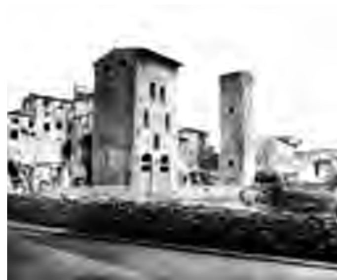
33 Le torri degli Amidei e dei Baldovinetti tra le macerie di via Por Santa Maria
