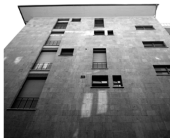
7 Particolare del fronte su via dello Sprone
