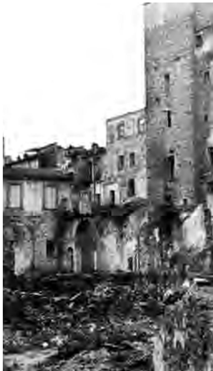
7 Le distruzioni intorno alle torri dei Ramaglianti
