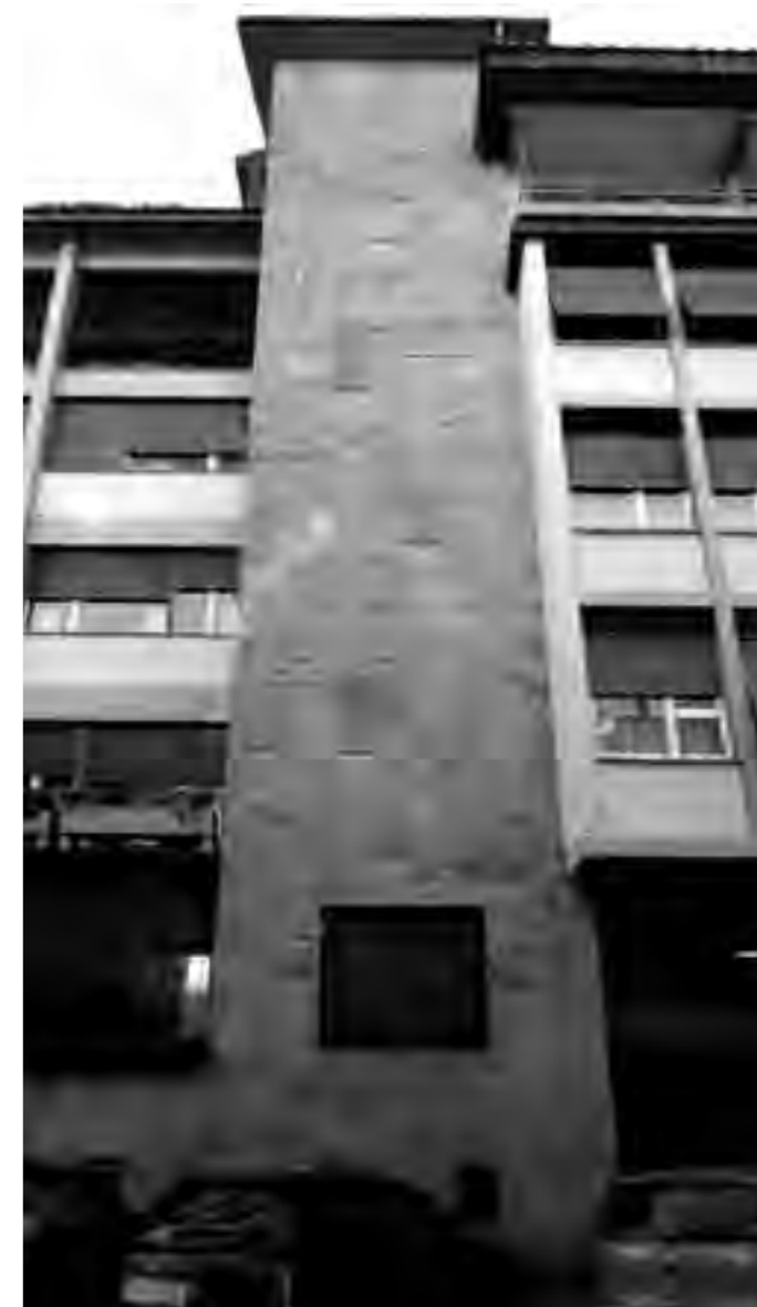
6 Particolare del fronte su via Guerrazzi
