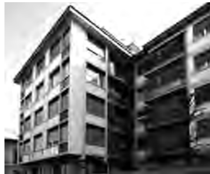
4 Scorcio del fronte su via Varchi
