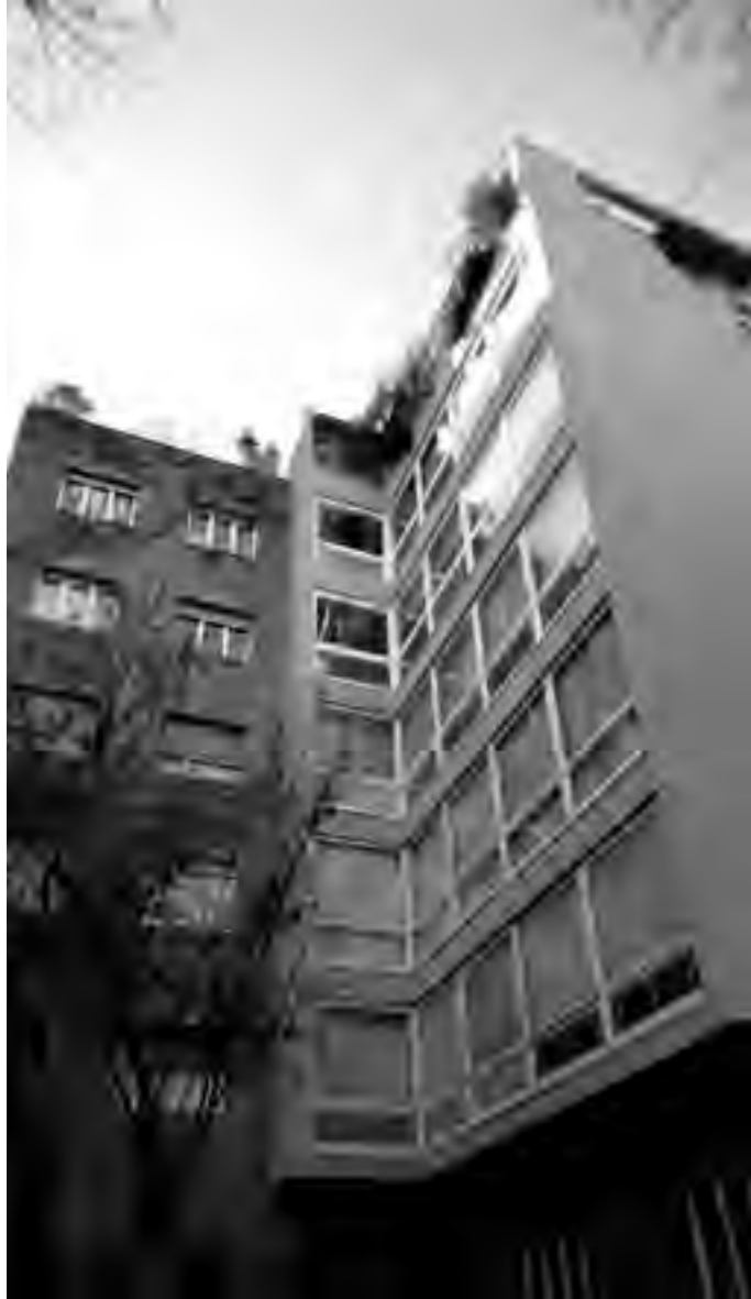
5 Veduta generale dell'edificio
