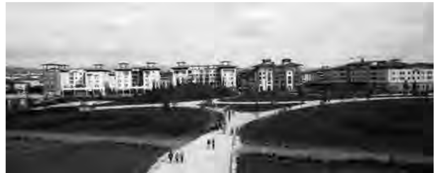
6 Veduta, dalla terrazza del Palazzo di Giustizia, dei prospetti sul parco (2009)
