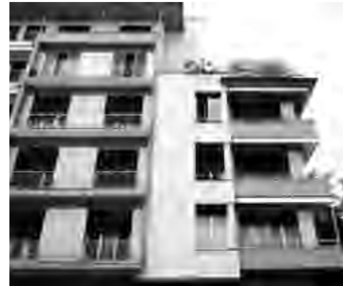
12 Particolare del fronte su via Guerrazzi
