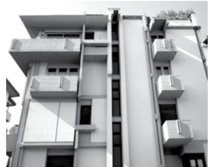
5 Scorcio del fronte su via Lanza
