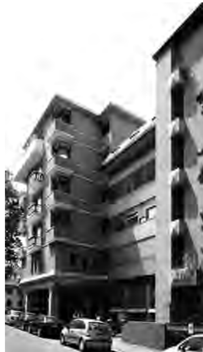
12 Scorcio del fronte su via Vanini
