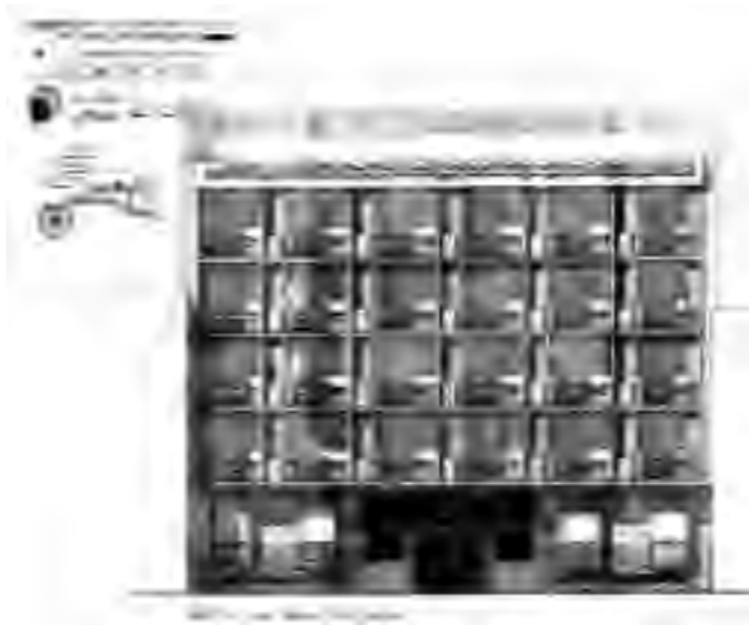
7 Prospetto su via Ficino
