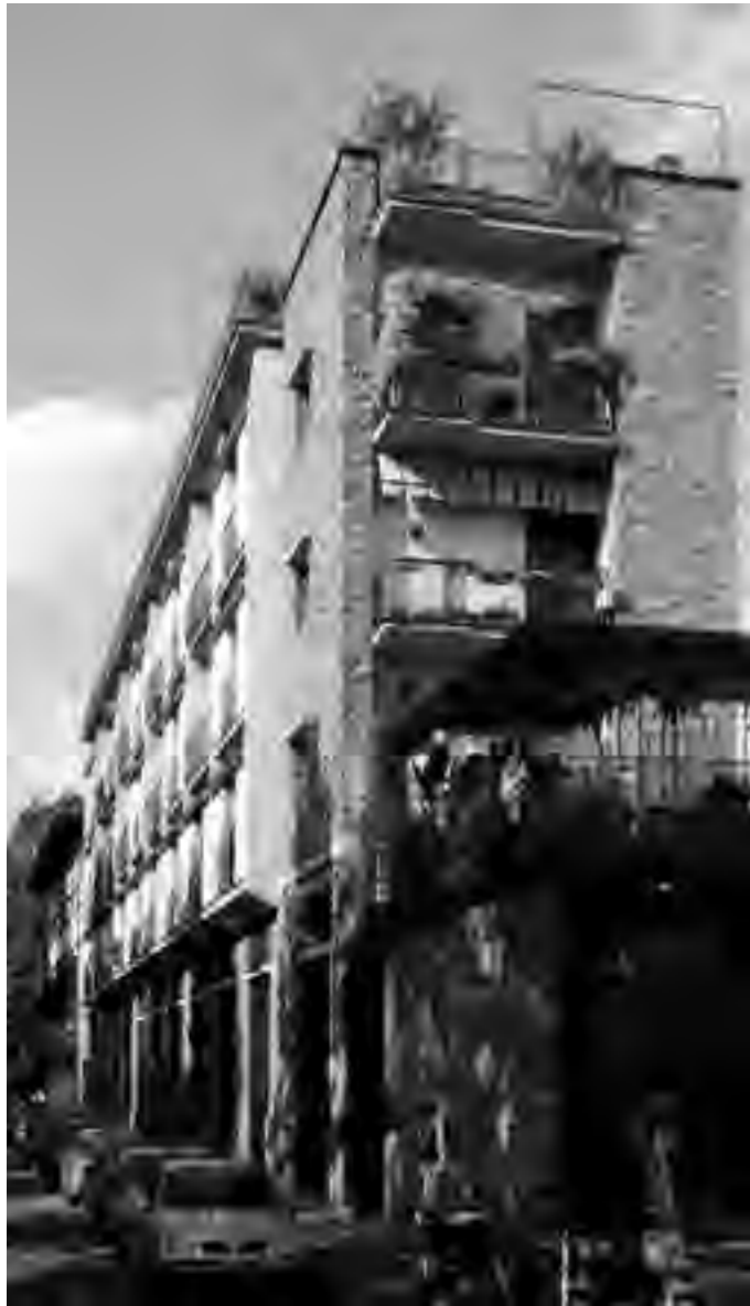
1 Scorcio del fronte su via Lungo le Mura di Santa Rosa
