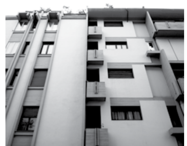
7 Scorcio del fronte su via Moriani
