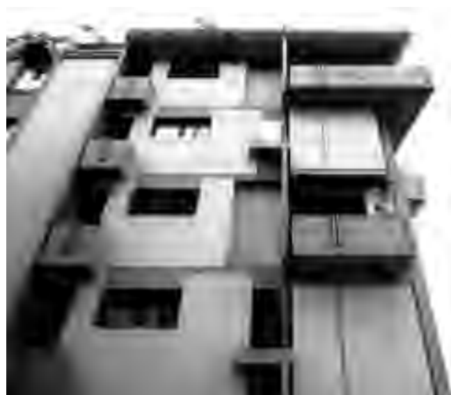
9 Scorcio del fronte su via Moriani
