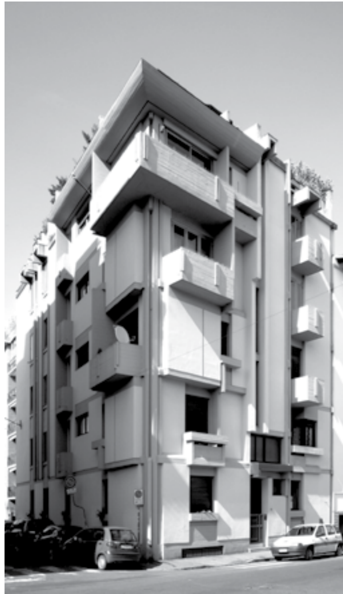
1 Veduta generale dell'edificio
