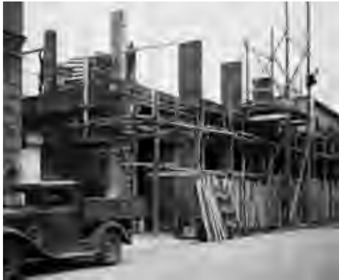
5 Il cantiere della sopraelevazione
