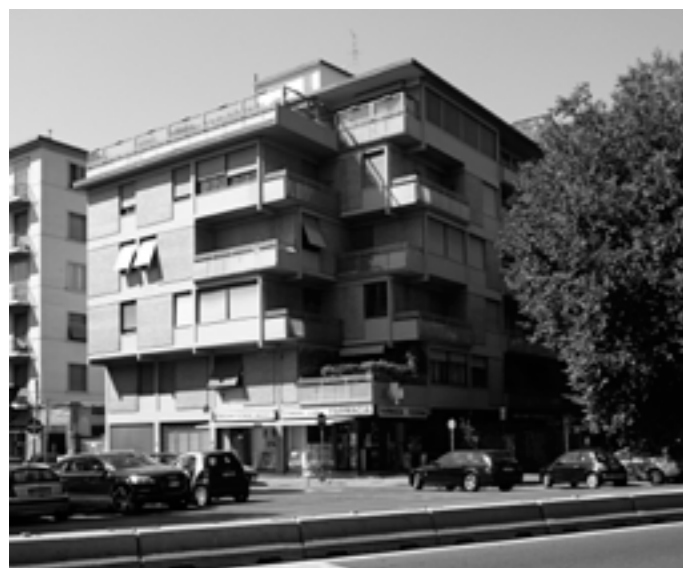
9 Veduta generale dell'edificio
