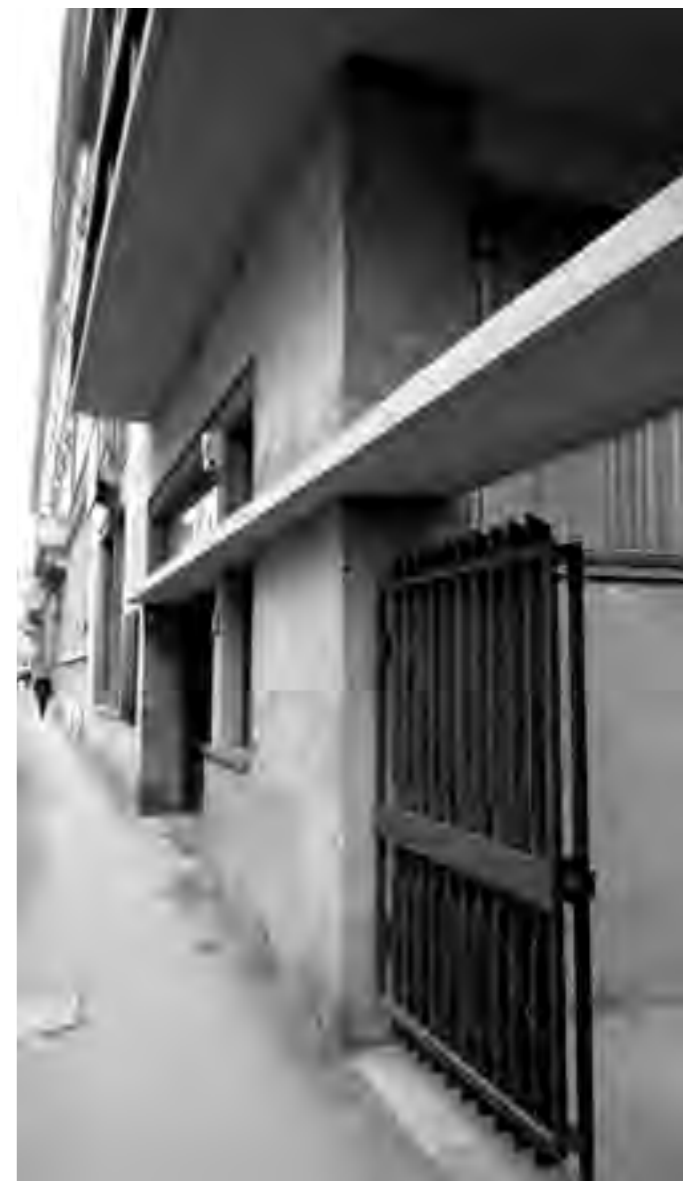
12 Particolare degli ingressi su via Lamarmora
