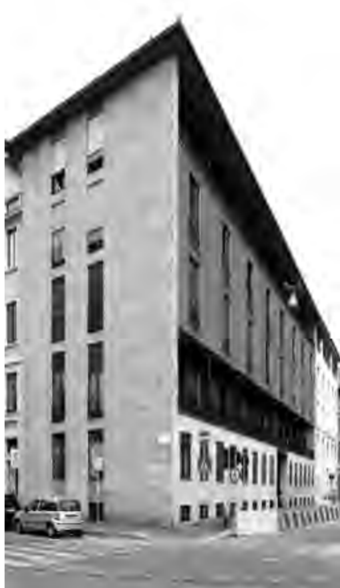
72 L. Caccia Dominioni, piazza Sant'Ambrogio, Milano, 1947-49 (veduta, 2012)
