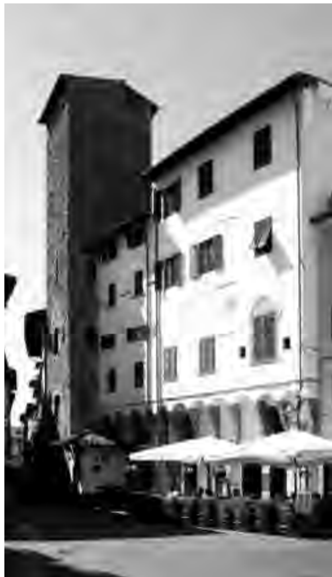
29 Veduta della torre Donati in piazza San Pier Maggiore
