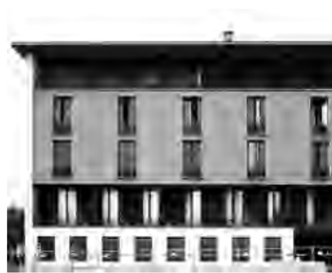
73 L. Caccia Dominioni, piazza Sant'Ambrogio, Milano, 1947-49 (veduta, 2012)
