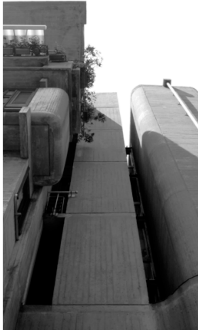
6 Particolare del vano scala e ascensore
