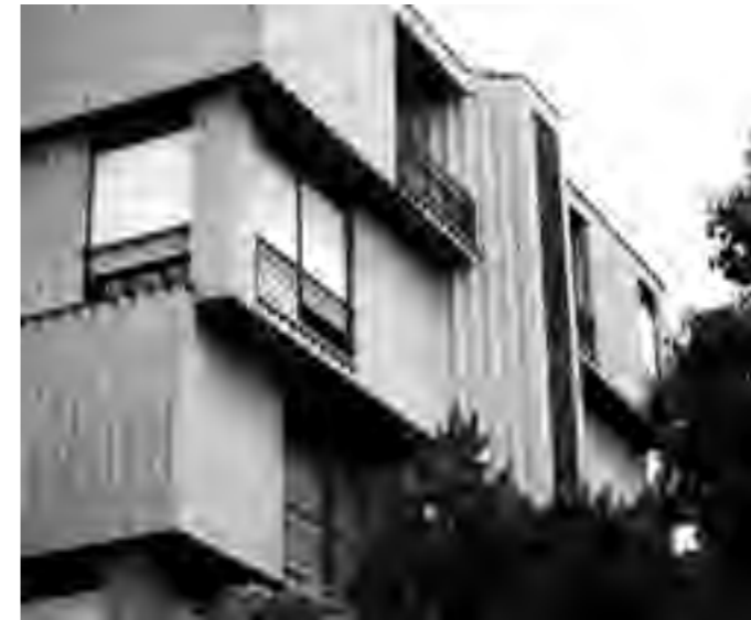
5 Scorcio del fronte sul giardino di ingresso
