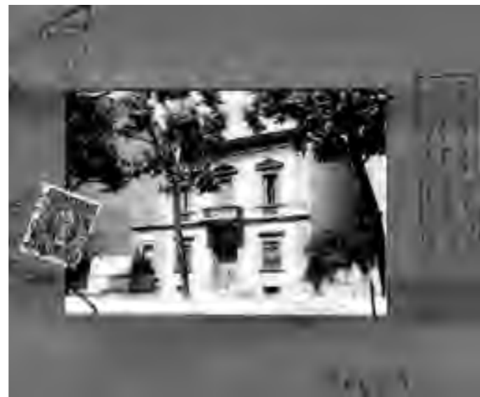
3 Veduta del villino preesistente
