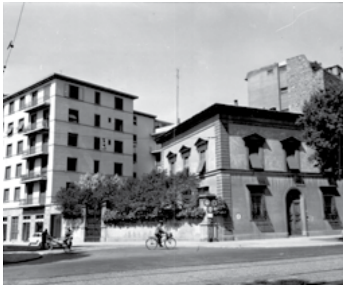
2 Veduta del villino preesistente
