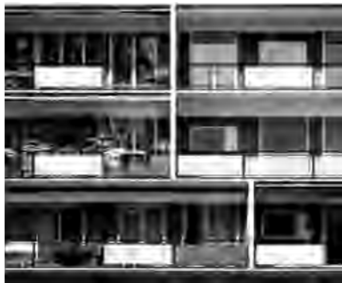
78 G. Ponti, via Dezza, 49, Milano, 1956-57 (veduta, 2012)
