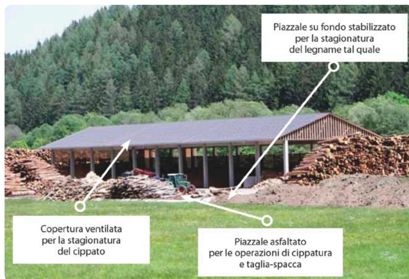
Struttura di una piattaforma. L'esempio della piattaforma Pölstal (Styria-Austria) (Fonte AA.VV. 2010)
