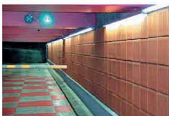
4. Vista del pannello «monopelle» in laterizio e relativo coefficiente di assorbimento acustico: al centro , per la semplice lastra in «cotto»; a destra , per la lastra in laterizio accoppiata all'isolante in lana di roccia; a sinistra , applicazione nel parcheggio del palazzo del Festival di Cannes.
