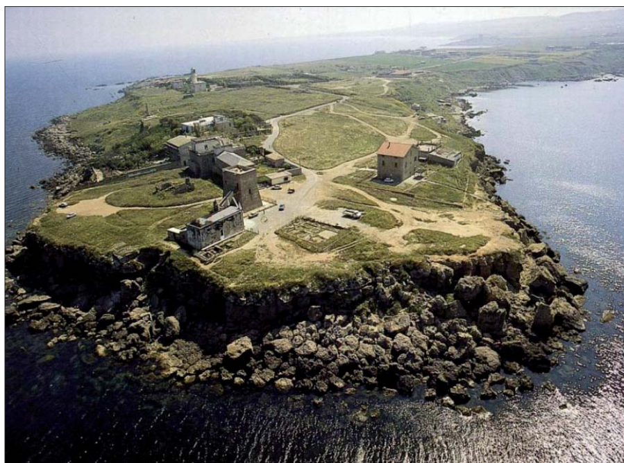
Figura 8 – Il promontorio di Capo Colonna. In primo piano lo stato di dissesto del complesso costituito dal Santuario della Madonna Nera, dalla torre di guardia cinquecentesca e dall'insediamento romano. Più lontana l'unica colonna superstite del tempio di Hera Lacinia.
