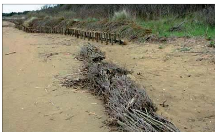
Figura 36 – Fascinate e palizzate a Vallevicchia, in provincia di Venezia.
