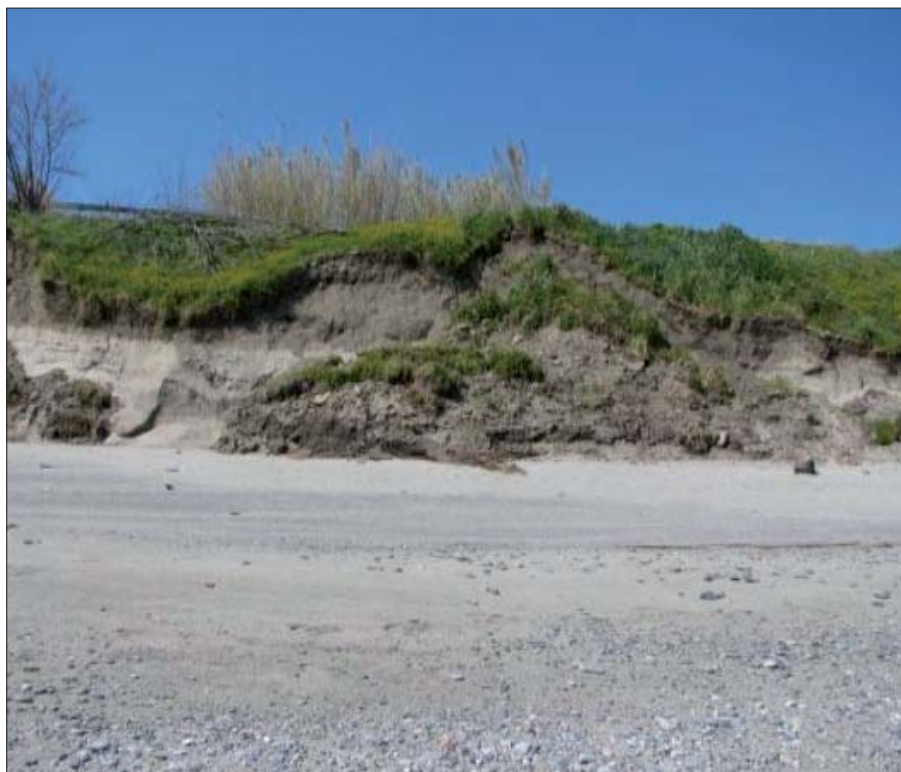
Figura 6 – La duna su cui poggia il tempio dorico alla fine della stagione invernale 2009-2010.
