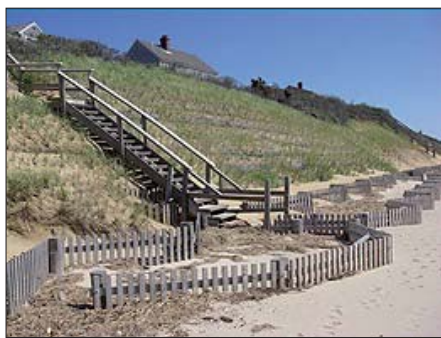
Figura 25 – Schermature e scale di accesso in legname in Olanda.
