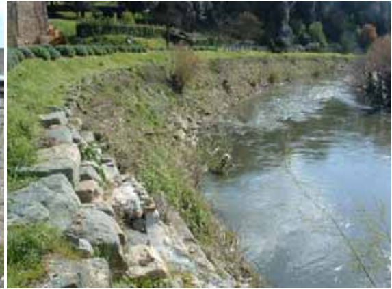
Fig. 5.109 – Rivestimento di sponda in pietrame
