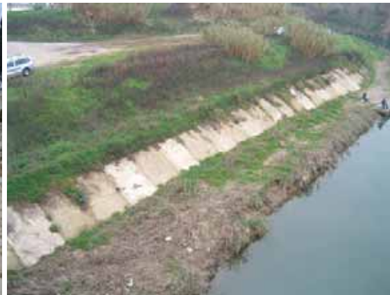
Fig. 5.38 – Rivestimento di sponda in calcestruzzo
