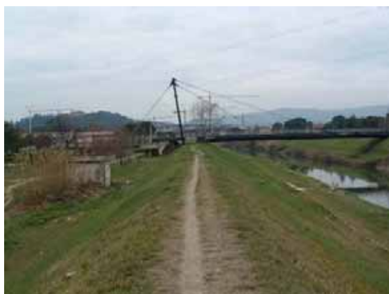
Fig. 5.96 – Argine in terra e passerella in lontananza
