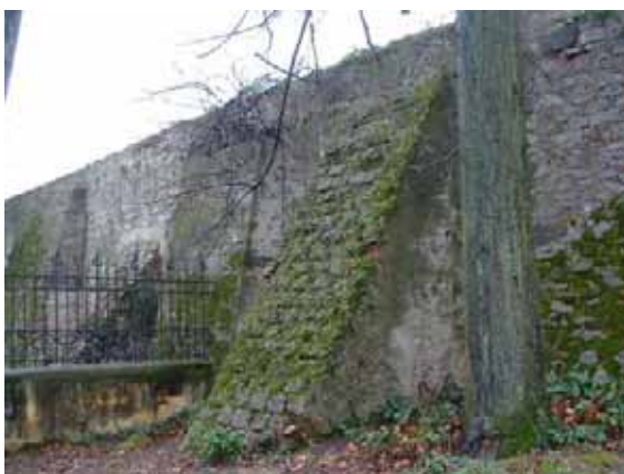
Fig. 5.88 – Muro d'argine sul lato esterno
