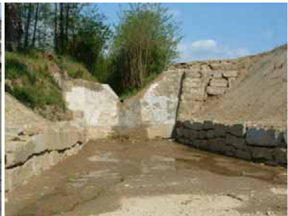
Fig. 5.46 – Briglia di un fosso secondario in zona di sponda
