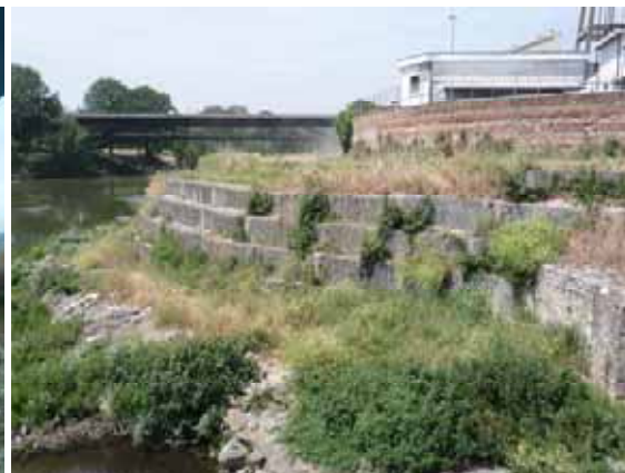
Fig. 5.40 – Muro di sponda in cemento gettato in opera
