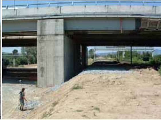
Fig. 5.28 - Argine in terra rinforzato con gabbioni
