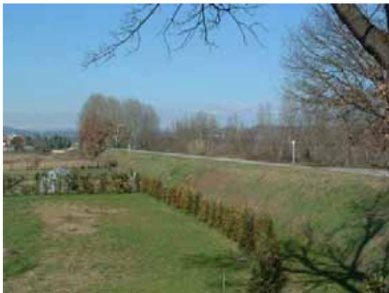
Fig. 5.31 - Argine in terra percorso da strada asfaltata
