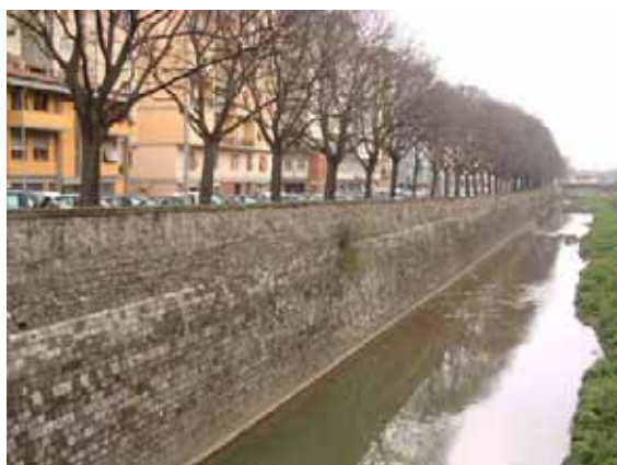
Fig. 5.123 – Muro d'argine che si estende in alveo
