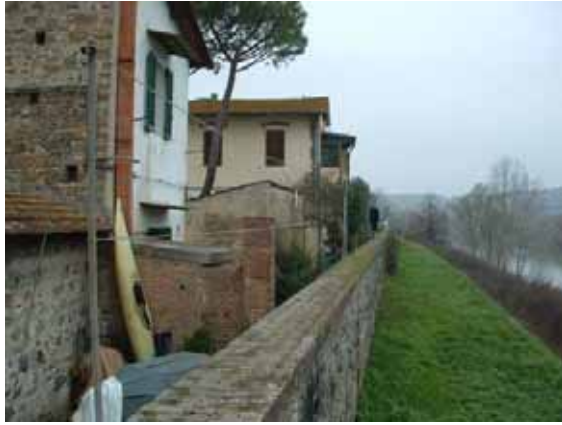
Fig. 5.21 – Muro d'argine a protezione dell'abitato
