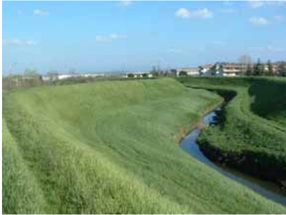
Fig. 5.113 – Rilevati arginali prossimi alla foce
