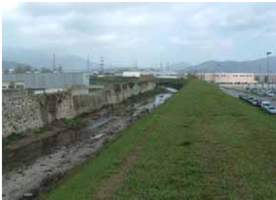
Fig. 5.86 – Argine in terra con rivestimento interno
