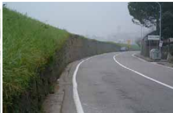
Fig. 5.34 - argine in terra accorciato e rinforzato con muratura
