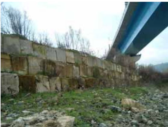
Fig. 5.39 – Muro di sponda in blocchi di cemento
