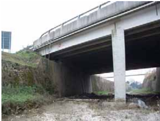
Fig. 5.92 – Ponte autostrada A11
