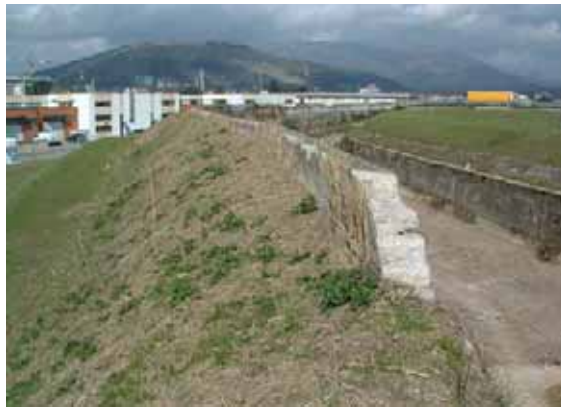
Fig. 5.87 – Argine misto con terra e muratura
