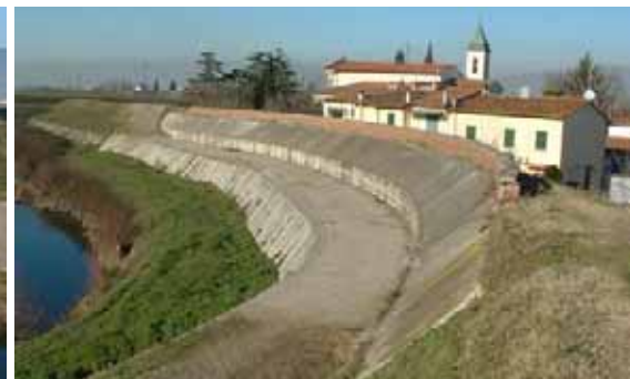
Fig. 5.78 – Argine in terra rivestito ed innalzato con muretto
