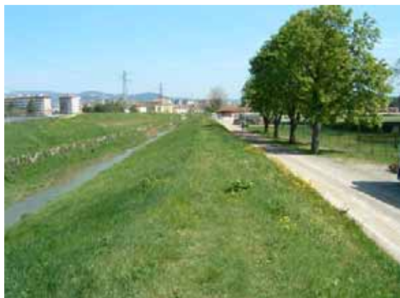
Fig. 5.121 – Rilevato arginale in zona cascine
