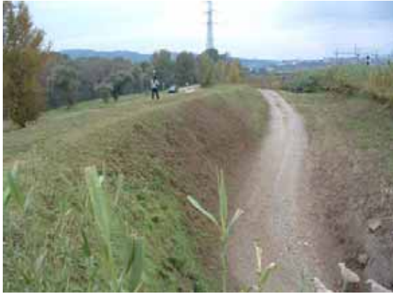
Fig. 5.27 - Argine in terra a protezione di un sottopasso
