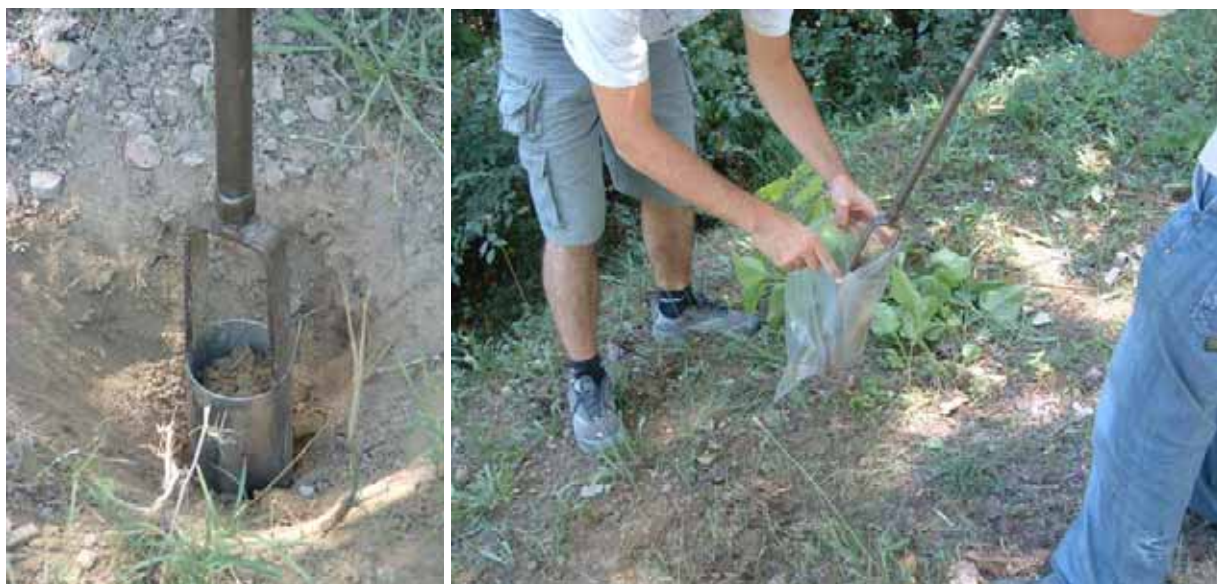
Fig. 7.5 - Esecuzione del foro e campionamento di terreno in argine.
