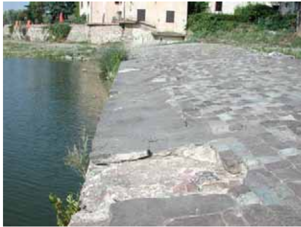
Fig. 5.145 - Lastre di pietra come rivestimento esterno del lato a valle (pescaia di S. Andrea a Rovezzano)
