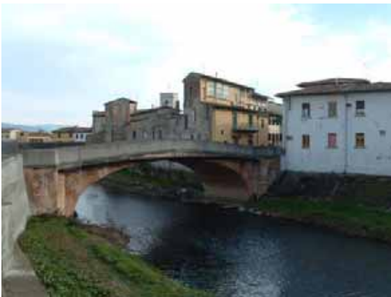
Fig. 5.83 – Ponte storico nel centro di Campi Bisenzio
