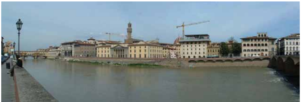
Fig. 5.24 – muro d'argine in lungarno generale Armando Diaz (destra) e in Lungarno Torrigiani (sinistra) (Firenze)
