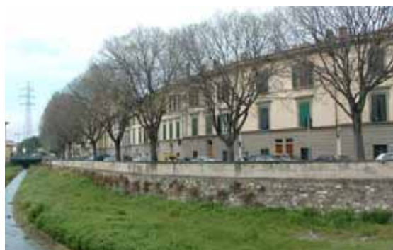
Fig. 5.130 – Muro d'argine che si estende in alveo
