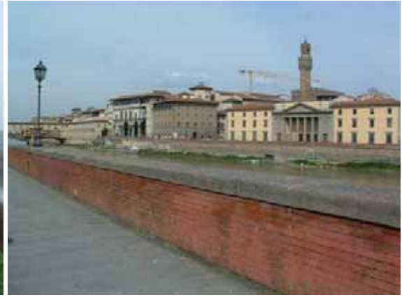
Fig. 5.22 – muro d'argine in lungarno Torrigiani (Firenze)
