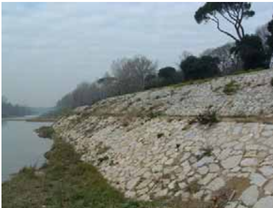
Fig. 5.37 – Rivestimento di sponda in muratura
