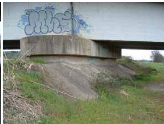
Fig. 5.138 – argine rivestito con addossamento di pilone
