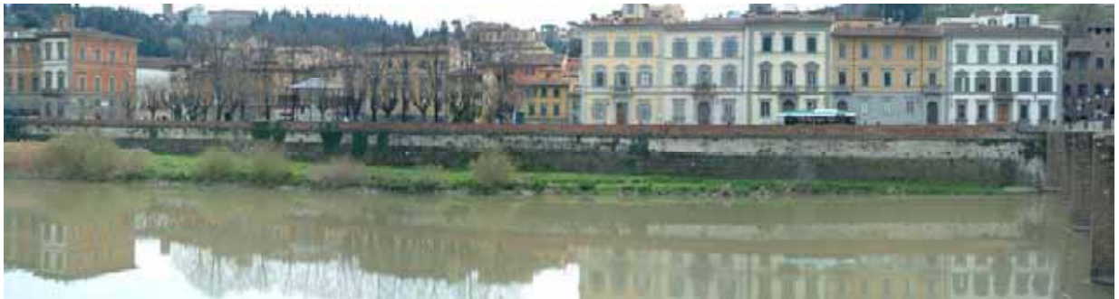
Fig. 5.23 – muro d'argine in lungarno Serristori (Firenze)
