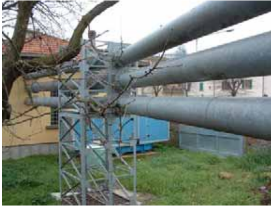
Fig. 5.43 – Tubazione uscente da un impianto idrovoro
