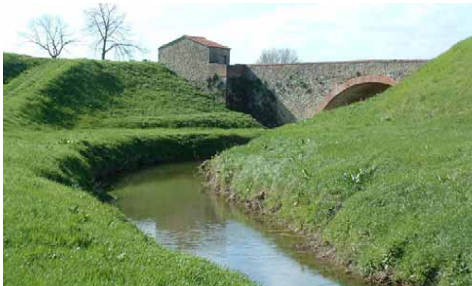
Fig. 3.11- Il torrente Vingone
