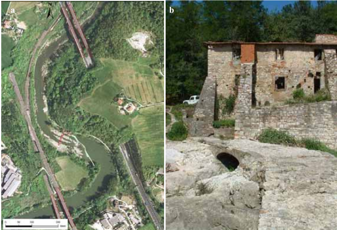
Fig. 5.52 – Foto aerea dell'area di imposta del Ponte di Annibale (a), ponte di Annibale e Mulino visto dal fiume (b)
