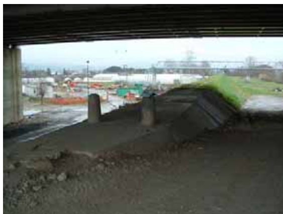
Fig. 5.137 – Argine rivestito sotto l'autostrada A1
