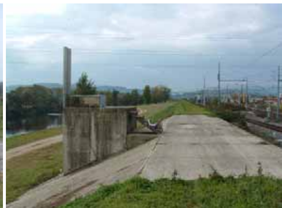
Fig. 5.26 - Argine in terra con manufatto
