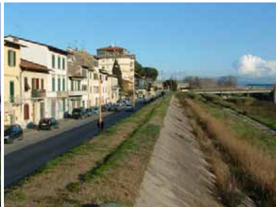
Fig. 5.30 - Argine in terra rivestito sui due fianchi
