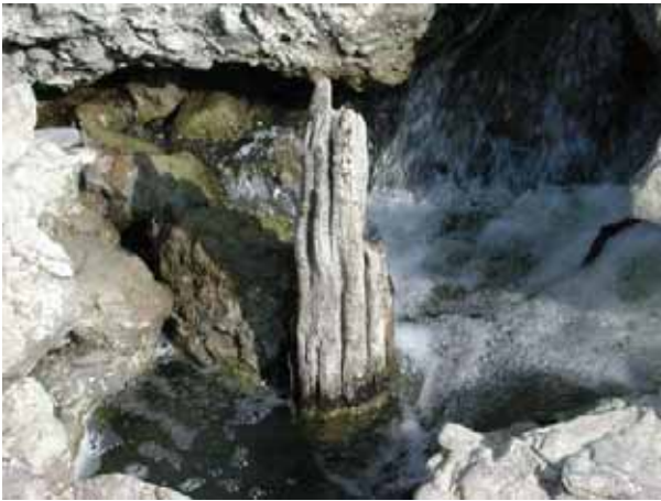
Fig. 5.144 - Palo di legno della originaria armatura (pescaia di S. Andrea a Rovezzano)
