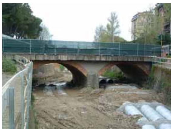
Fig. 5.125 – Ponte all'Asse durante la cantierizzazione
