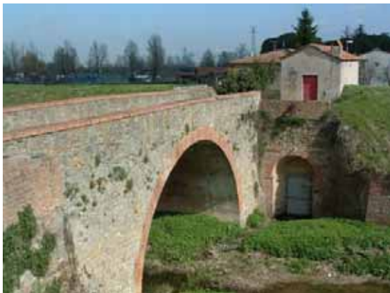
Fig. 5.117 – Ponte stradale e scarico adiacente
