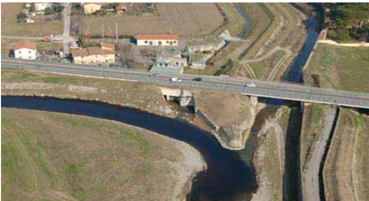
Fig. 5.73 Particolare dell'impianto di Crucignano
