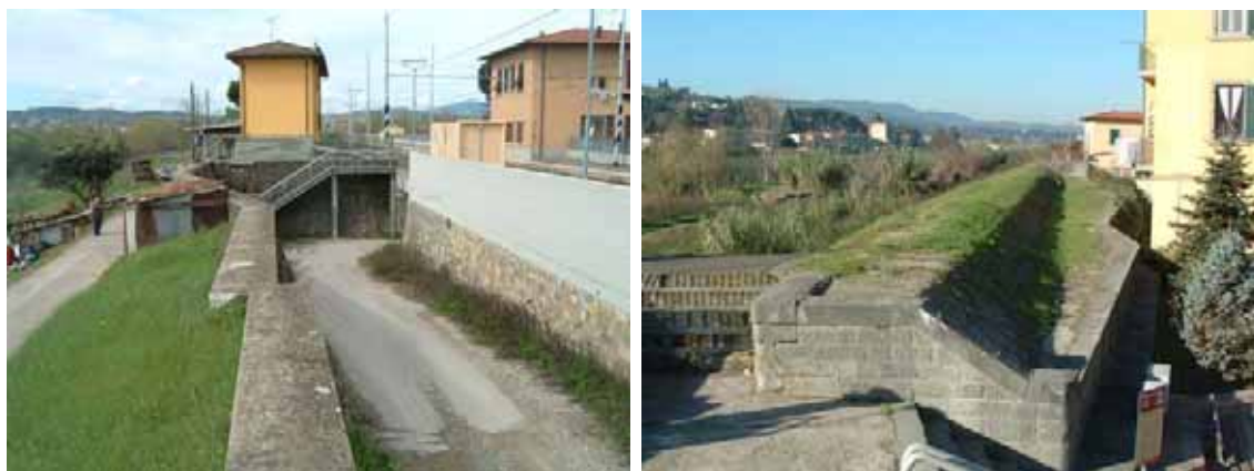
Fig. 5.35 – argine misto terra-muratura in zona ferroviaria Fig. 5.36 – argine misto terra-muratura
