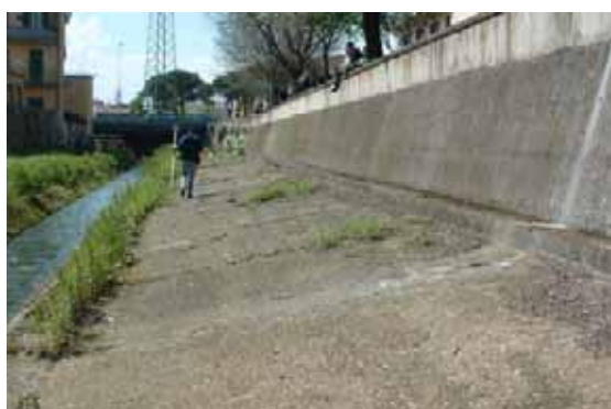
Fig. 5.132 – Muro e rivestimento in cemento dell'alveo
