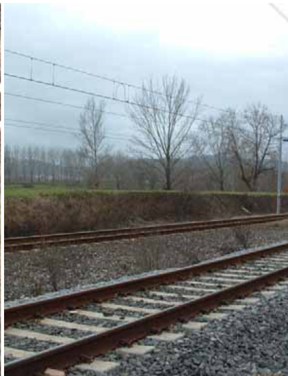
Fig. 5.136 – superficie ferroviaria sul banco intermedio
