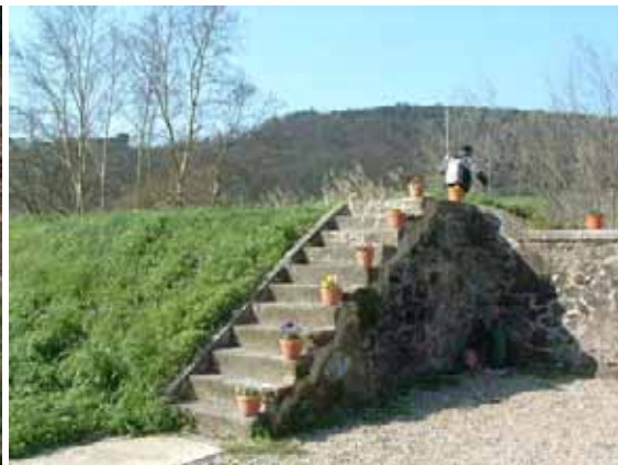
Fig. 5.32 - zona di contatto tra argine in terra e muratura
