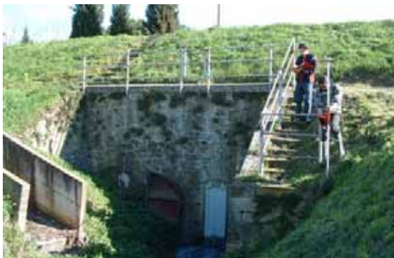
Fig. 5.33 - argine misto terra-muratura in zona di scarichi
