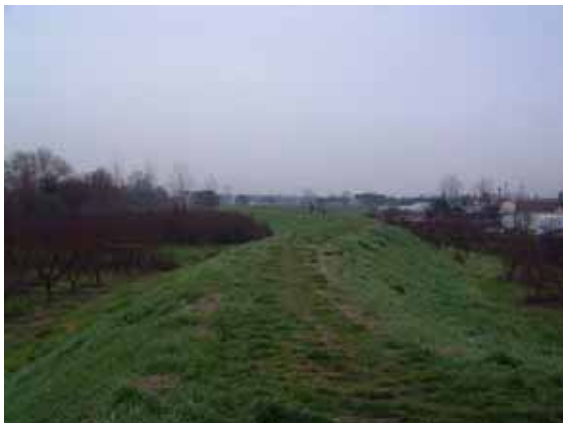
Fig. 5.29 - Argine in terra in zona di campagna
