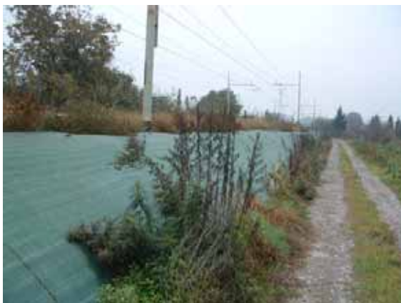
Fig. 5.25 - Argine in terra con telo di rivestimento
