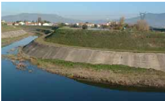
Fig. 5.77 – Argine in terra e rivestimento di sponda
