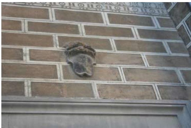
Particolare del trattamento delle lacune
