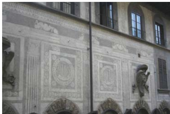
Palazzo n° 28, particolare del trattamento delle lacune
